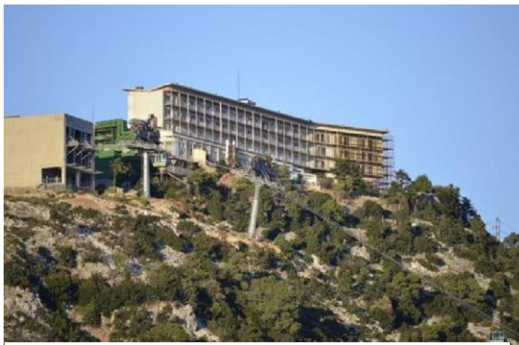
Εικόνα 5. Καζίνο Mont Parnes, Πάρνηθα.
