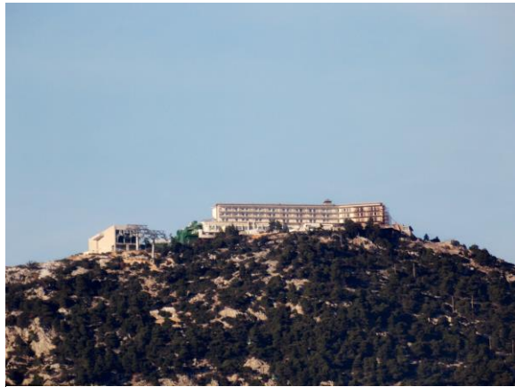
Εικόνα 4. Καζίνο Mont Parnes, Πάρνηθα.
