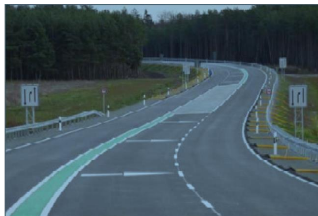
Εικόνα 35: Τμήμα οδού κλάσης EKL 1 Πηγή: Νικολέτου 2018
