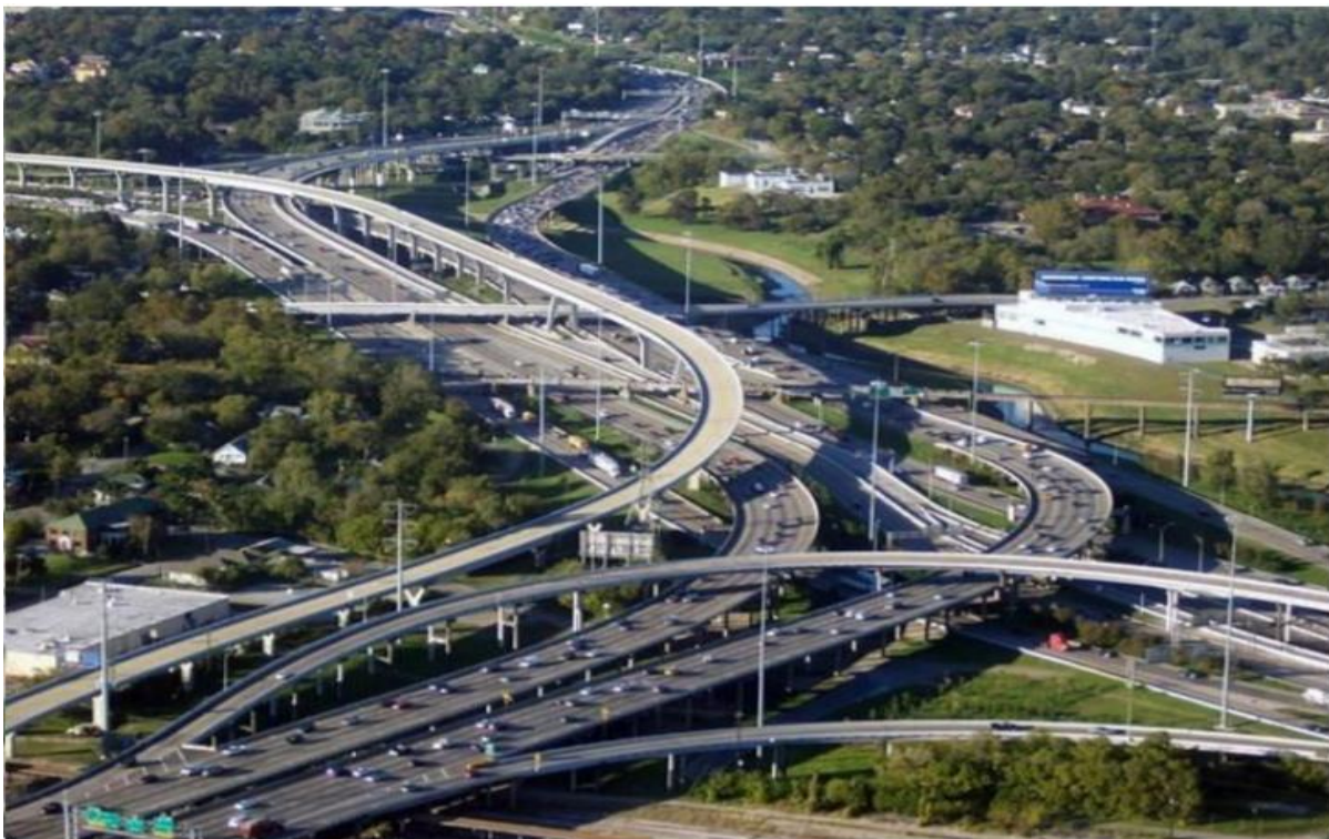
Εικόνα 2: Ανισόπεδος κόμβος Houston Texas
