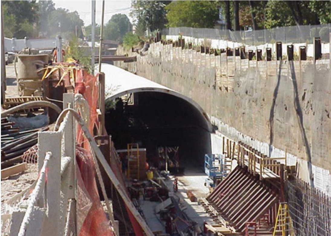
Εικόνα 4: Η μέθοδος cut and cover (1)
