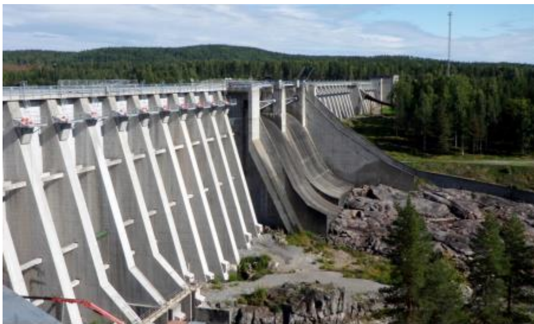
Εικόνα 20: Παράδειγμα αντηριδωτού φράγματος (Fu C., Hafliðason B., 2015)
