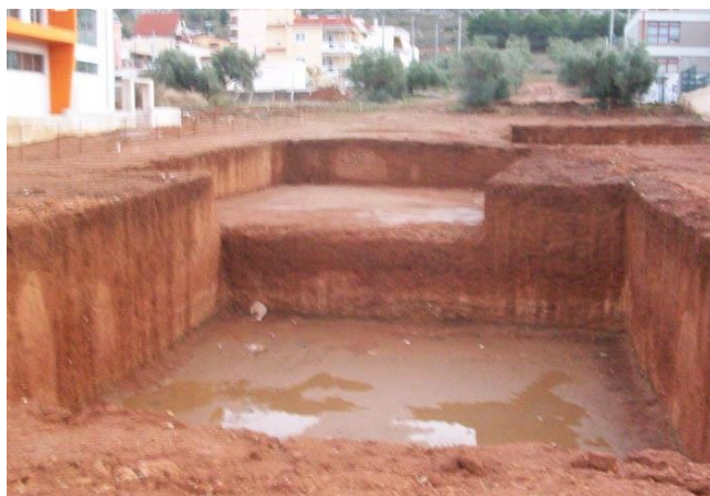
Εικόνα 28. Ενδεικτική Τελική μορφή εκσκαφών 2 επιπέδων
