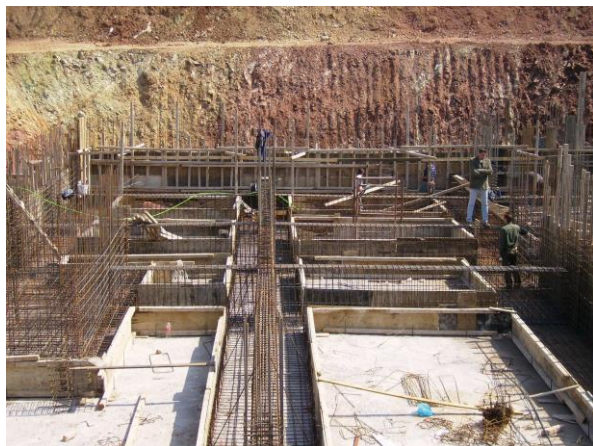
Εικόνα 33. Ενδεικτική Τοποθέτηση οπλισμού θεμελίων
