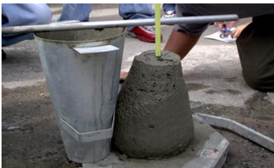
Εικόνα 35. Δοκιμή κάθισης Σκυροδέματος με Κώνο Abraams.
