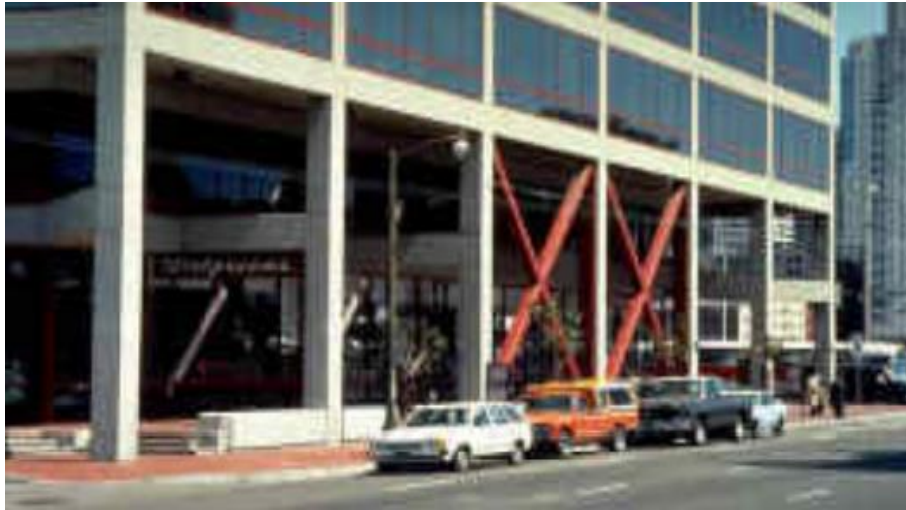
Σχήμα 1.2: Χρήση δικτυωτού χιαστί συνδέσμου σε πολυώροφο κτίριο.
