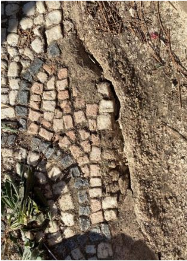
Εικόνα 151. Ρωγμή μεταξύ ψηφιδωτού και κονιάματος πριν την πλήρωση με κονίαμα.
