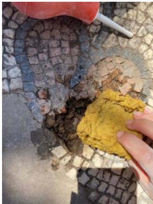
Εικόνα 157. Η περιοχή που διαβρέχεται πριν την τοποθέτηση τους κονιάματος.
