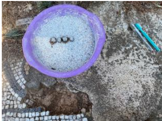
Εικόνα 154. Η τοποθέτηση ψηφίδων με τη σωστή διάταξη στην αμμοδόχο πριν την επανατοποθέτηση.
