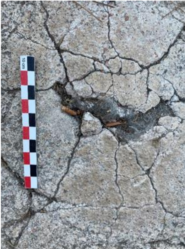
Εικόνα 177. Απώλεια σε κονίαμα από προγενέστερη επέμβαση πριν τη συντήρηση.
