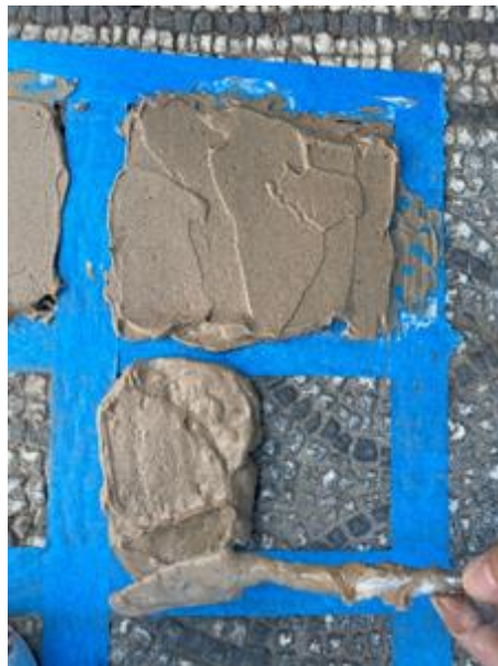
Εικόνα 116. Κατά τη διάρκεια εφαρμογής της Πάστας Μοσα με τη χρήση σπάτουλας.
