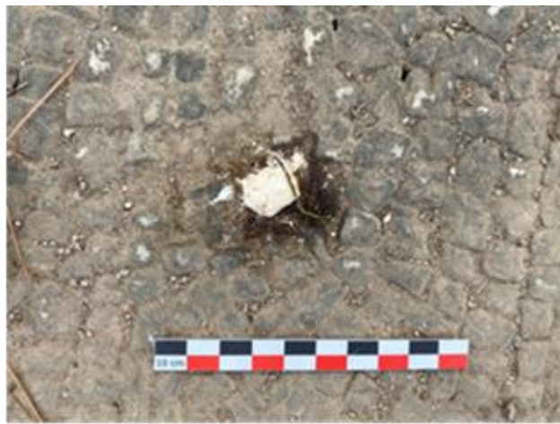
Εικόνα 40. Περιττώματα πτηνών, επάνω στη ψηφιδωτή επιφάνεια.
