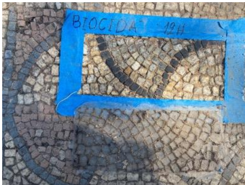
Εικόνα 141. Η ψηφιδωτή επιφάνεια μετά την ολοκλήρωση του καθαρισμού του Biocida.
