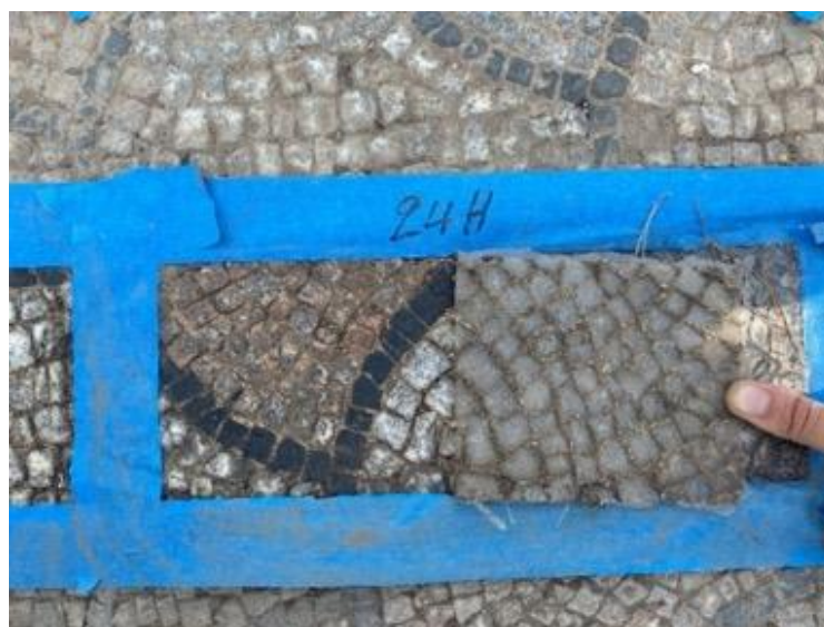
Εικόνα 143. Κατά τη διάρκεια αφαίρεσης του Biocida.
