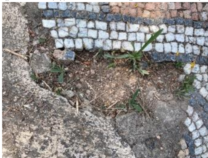
Εικόνα 45. Συσσώρευση χώματος στις απώλειες, η δημιουργία μικρών φυτών και η σταδιακή χαλάρωση συνοχής των ψηφίδων.
