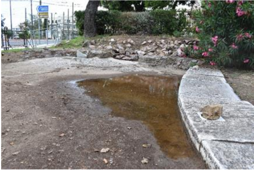
Εικόνα 33. Περιοχή με λιμνάζοντα νερά από την πλευρά στην οδό Βασιλίσσης Όλγας.
