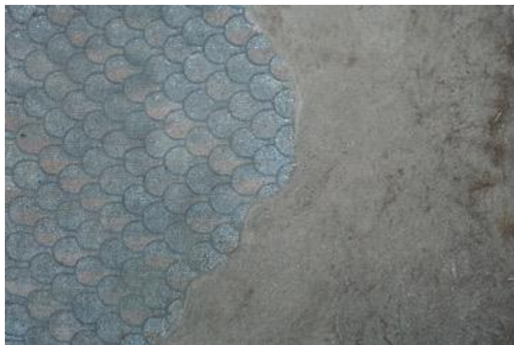
Εικόνα 79. Το κονίαμα πλήρωσης στο κέντρο του δαπέδου. Διατηρείται γενικά σε καλή κατάσταση.
