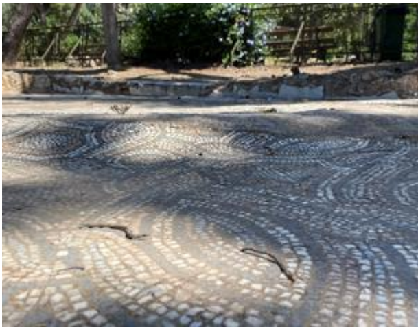
Εικόνες 76-77. Εξάρσεις α) κοντά σε περιοχή με δέντρα β) Η υψομετρική διαφοροποίηση που εκδηλώνεται στην επιφάνεια από την εξάρση
