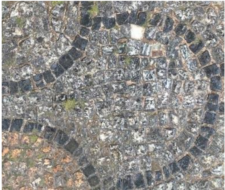
Εικόνα 67. Οι νεκρωμένες λειχήνες δημιουργούν μαύρες επιστρώσεις πάνω στις ψηφίδες. Προκαλείται χρωματική αλλοίωση, οι λευκές φαίνονται μαύρες.
