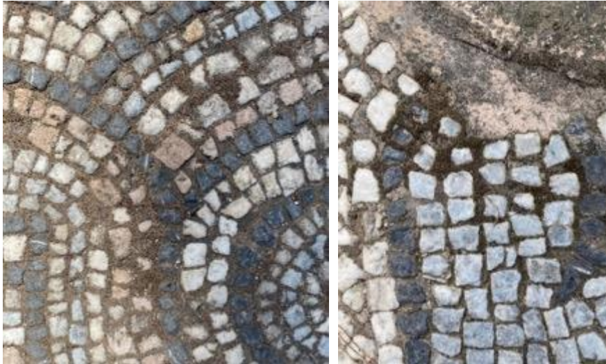
Εικόνες 68-69. Ανάπτυξη θρύων παρατηρείται να είναι εντονότερη ενδιάμεσα των ψηφιδών.
