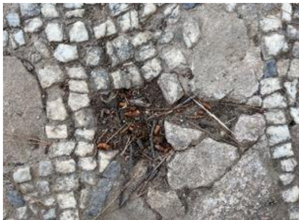
Εικόνα 72. Αποκόλληση και απώλεια ψηφίδων.
