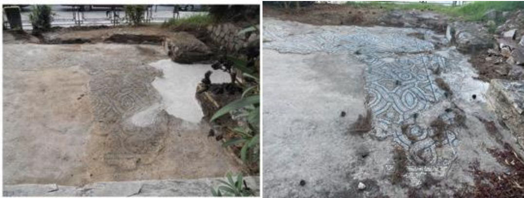
Εικόνες 85-86. Στην αριστερή εικόνα παρατηρείται το κονίαμα, που προστέθηκε κατά την συντήρηση του ψηφιδωτού το 2013 και στην δεξιά εικόνα το ίδιο κονίαμα του έτους 2022.
