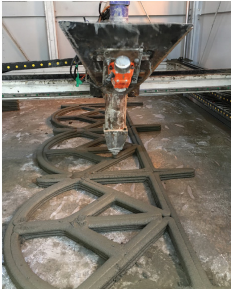
Εικόνα 7. Κατασκευή περιγράμματος.
