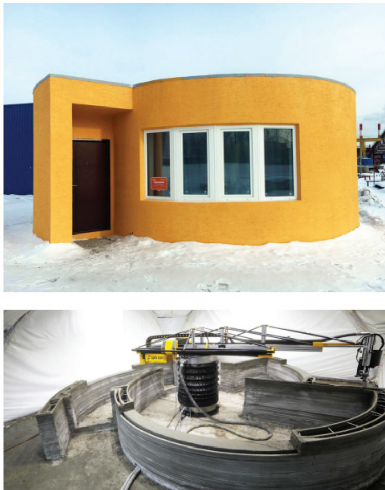
Εικόνα 11. Πάνω: Τελειωμένο εκτυπωμένο σπίτι 38m 2 από την ApisCor/PIK Κάτω: Κινητός 3D printer επί τω έργω.
