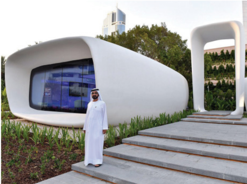
Εικόνα 12. Κτίριο γραφείων Winsun/Gensler
