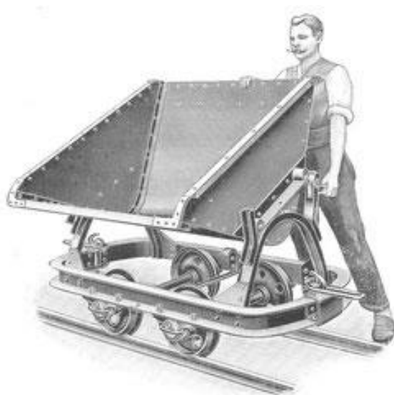
Εικόνα 14 : Πως χρησιμοποιούταν η τροχήλατη βάση με τον κουβά μεταφοράς υλικών , πηγή: (Bongaards, 2011)
