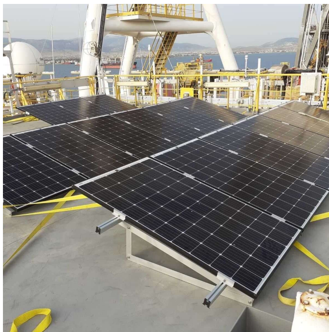
ΕΙΚΟΝΑ 2-6: Αυτόνομα Φ/Β συστήματα σε πλοίο εξόρυξης πετρελαίου Πηγή: (photovoltaic.gr, 2022)
