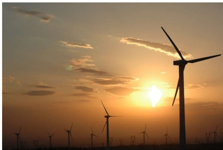
ΕΙΚΟΝΑ 1-2: Εγκαταστάσεις αιολικής ενέργειας στην Κίνα (Σιντσιάνγκ) Πηγή: (Wikipedia - 2005)
