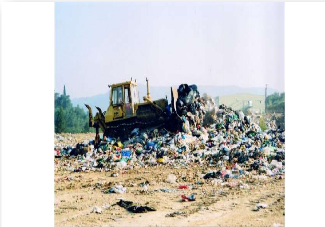
Εικ. 2.5.1: Μια μπουλντόζα συμπίεσης αστικών απορριμμάτων που παραδόθηκε πρόσφατα στον χώρο υγειονομικής ταφής του Τεμπλονίου στο νησί της Κέρκυρας. Σε απόσταση; μπορείτε επίσης να δείτε τη νέα Εγκατάσταση Ανακύκλωσης Υλικών (MRF) για την επεξεργασία σύνθετων ανακυκλώσιμων υλικών. Πηγή (EC-Europa.eu 2014a).
