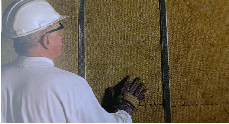
Στερέωση ξυλόμαλλου σε τοιχοποιία. (Εικόνα 16)
