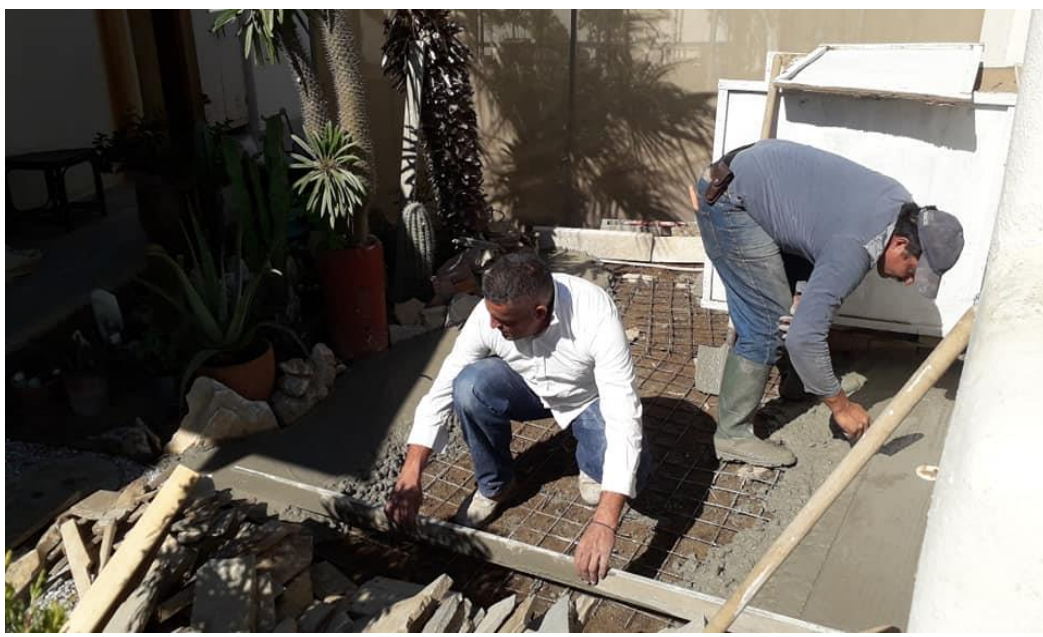
Τίτλος: Ρίξιμο μπετόν ύστερα από σιδέρωμα δαπέδου
