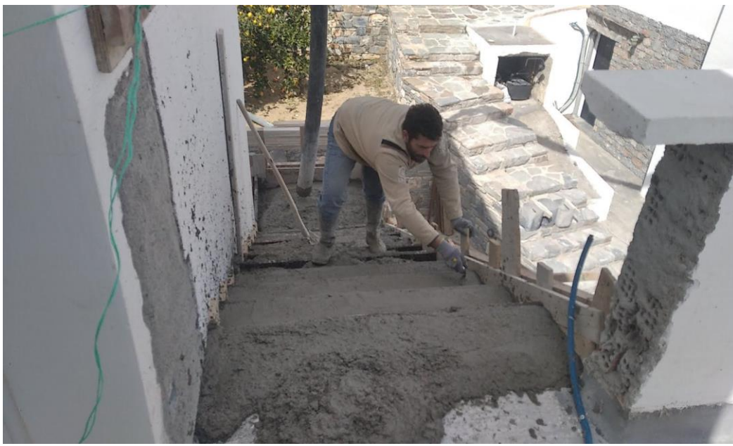
Τίτλος: Στρώσιμο της σκάλας από σκυρόδεμα
