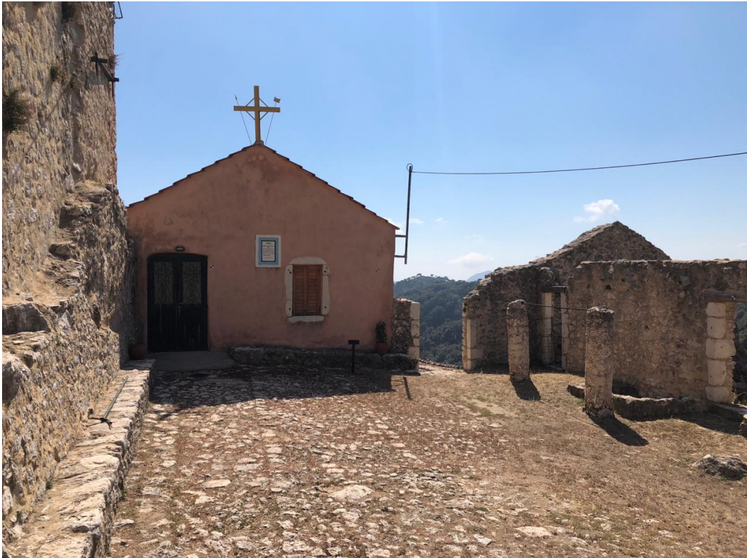
Εικόνα 10. Ο ξενώνας που ανεγέρθη το 1906 και δεξιά του το κτίριο που αποτελούσε τα κελιά
