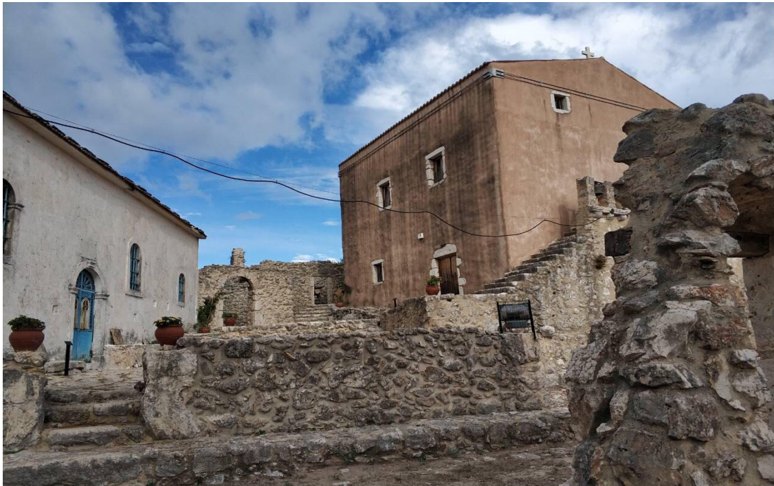
Εικόνα 5. Ο μεσαιωνικός αμυντικός πύργος και η εκκλησία της Μονής
