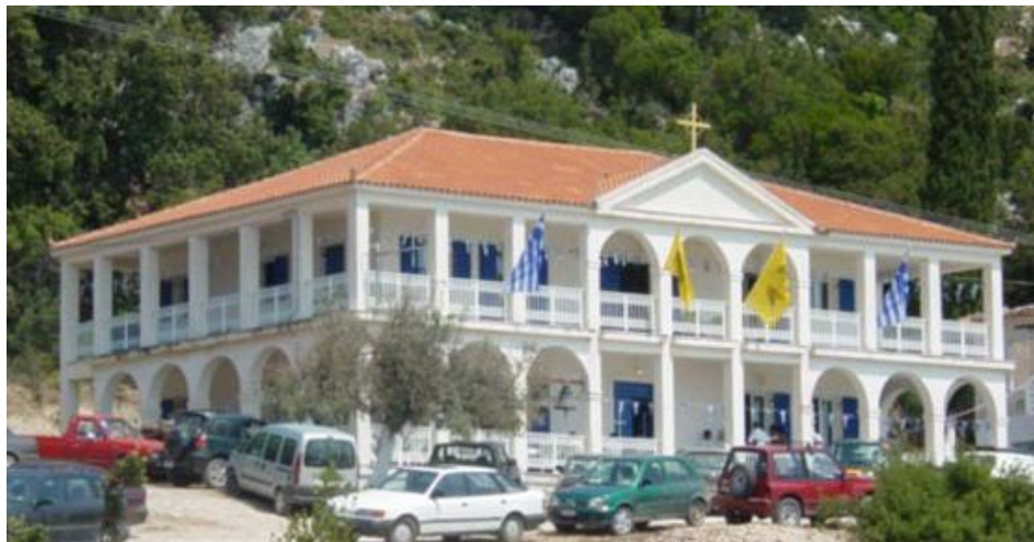
Εικόνα 12. Το νεότερο κτίσμα της μονής που λειτουργεί ως ηγουμενείο και κατοικία καλογέρων [39]
