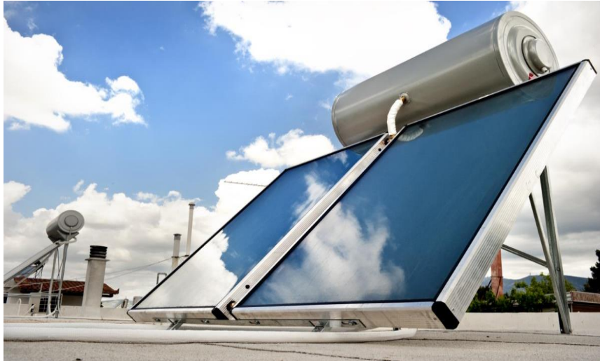
Εικόνα 39 Ηλιακός θερμοσίφοντας φυσικής κυκλοφορίας (πηγή: https://volton.gr )
