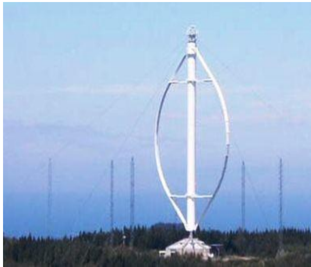
Εικόνα 44 Ανεμογεννήτρια κατακόρυφου άξονα
