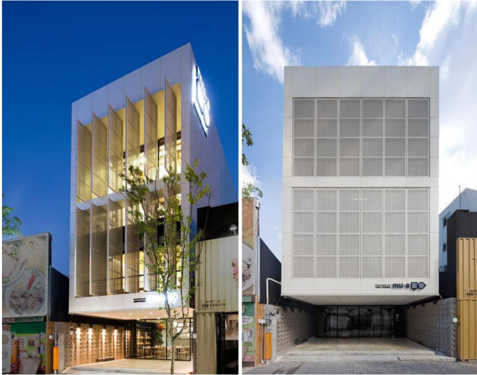
Εικόνα 29 Κινούμενα πετάσματα σκίασης σε όψη κτηρίου (πηγή: https://www.ktirio.gr )
