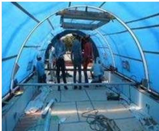
Εικόνα 56. Κατασκευή Υποβρύχιας Κατασκευής. Πηγή: A Study on the Developing concepts of Underwater Construction .
