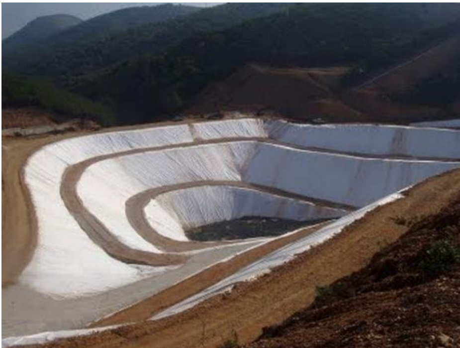
Εικόνα 26. Χώρος Υγειονομικής Ταφής Απορριμμάτων. Πηγή: Στερεά απόβλητα και η διαχείρισή τους στο Δήμο Πύργου», σελίδα 21
