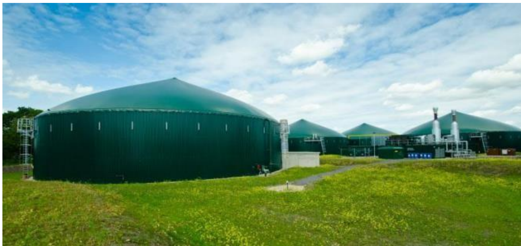
Εικόνα 27. Εγκαταστάσεις στις οποίες γίνεται αναβάθμιση βιοαερίου στο Carertown. Πηγή: «Παραγωγή Βιομεθανίου από Στερεά Απόβλητα», σελίδα 11.
