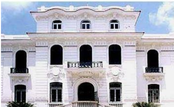
Εικόνα 2. Μουσείο Αλεξάνδρειας. Πηγή Tour Egypt.
