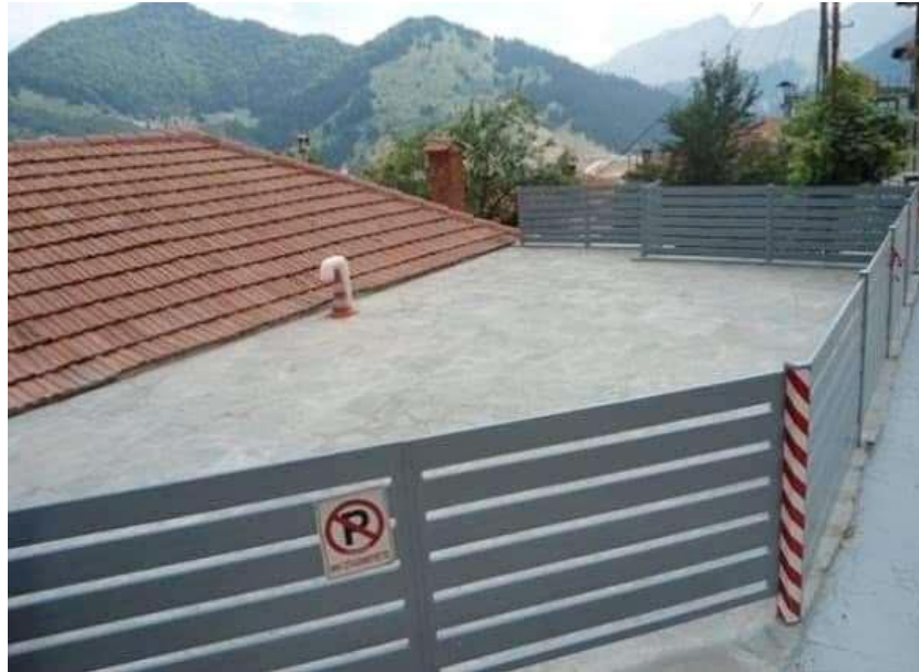
Εικόνα 2.9) Στεγανοποίηση και θερμομόνωση ταράτσας στο Μέτσοβο.
