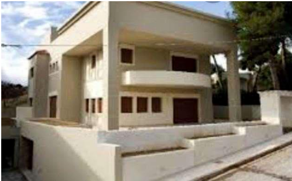
Εικόνα 8.8) Από τα πρώτα πιστοποιημένα παθητικά κτίρια βρίσκεται στην περιοχή της Πεντέλης
