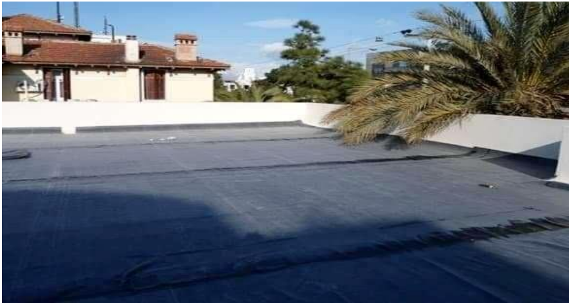
Εικόνα 8.1) Στεγανοποίηση και θερμομόνωση ταράτσας στο Παλαιό Ψυχικό
