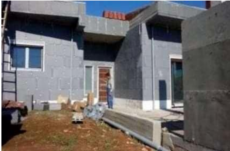
Εικόνα 2.3) Μόνωση κελύφους.
