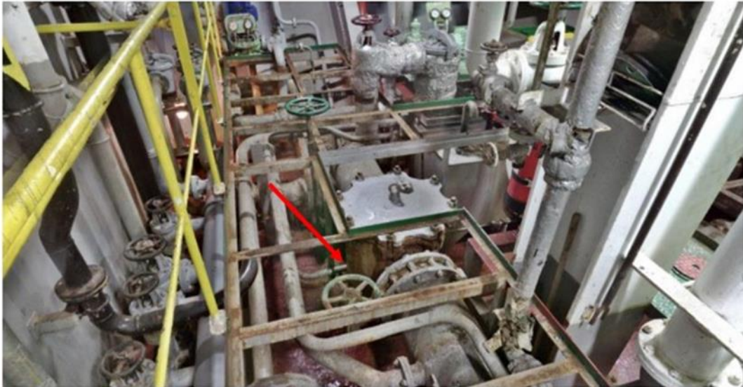
Εικόνα 20: Τρισδιάστατη απεικόνιση της όδευσης των σωληνώσεων του συστήματος έρματος στο Low Sea Chest, E/R Lower Floor
