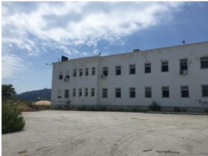
Εικόνα 24 Δυτική όψη του κτιρίου
