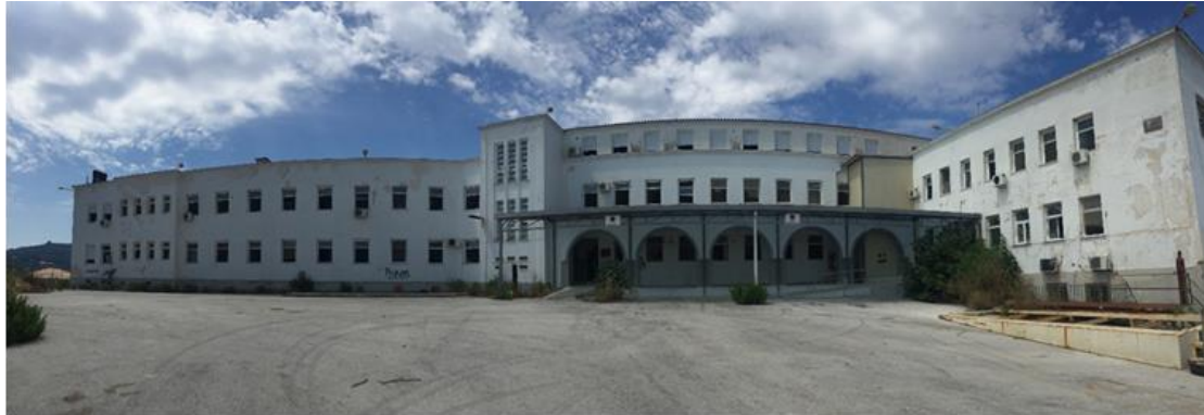
Εικόνα 18 Πρόσψη των κτιρίων από την οδό Αγ. Σπυρίδωνος
