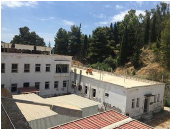
Εικόνα 22 Βορειοανατολική όψη των κτιρίων
