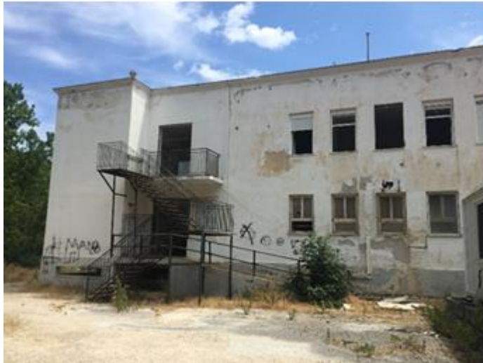
Εικόνα 23 Βορειοανατολική όψη των κτιρίων
