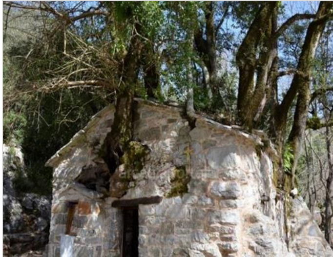
Εικόνα 6: Δράση φυτών σε τοιχοποιία διατηρητέου ναού. Πηγή: https://www.arcadiaportal.gr/ .
