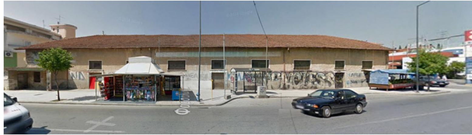
Εικόνα 4. Όψη κτιρίου επί της οδού Φαρσάλων
