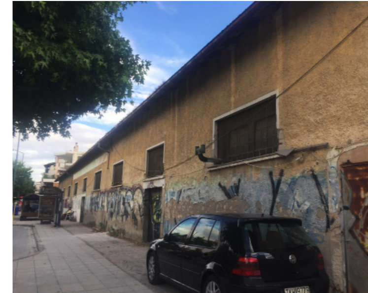
Εικόνα 5. Το κτίριο επί την οδό Φαρσάλων
