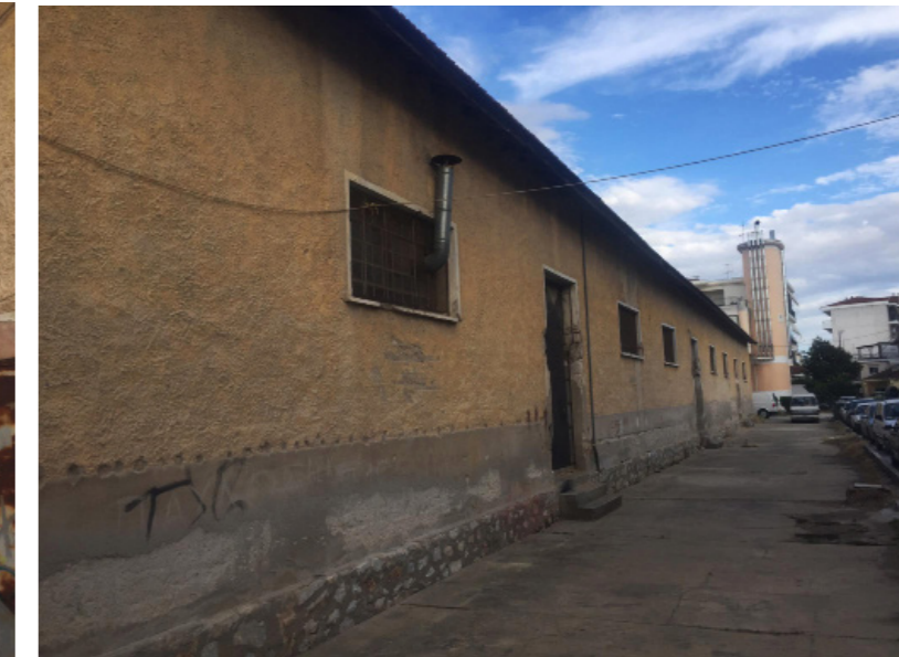
Εικόνα 6. Το κτίριο επί την οδό Καλύμνου
