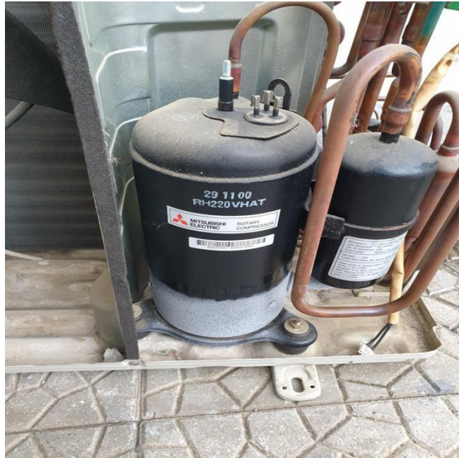
Figure 8: Συμπιεστής Rotary 12000btu
