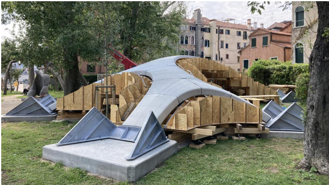
Εικόνα 3.2.12 Στάδια κατασκευής της γέφυρας Striatum
