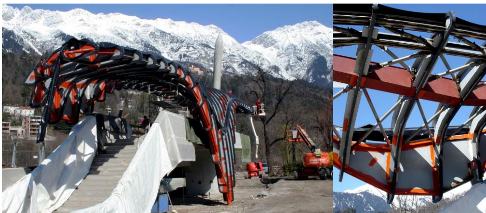
Εικόνα 3.1.16 Κατασκευή του χαλύβδινου σκελετού με τις λωρίδες πολυαιθυλενίου
