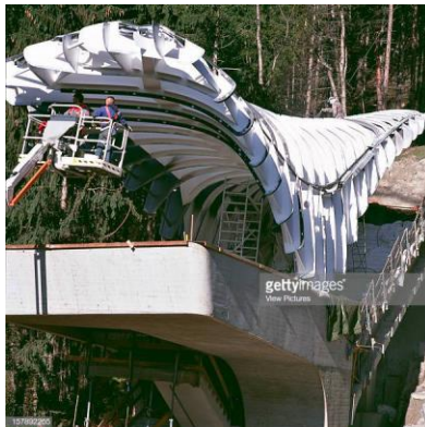
Εικόνα 3.1.15 Κατασκευή του χαλύβδινου σκελετού
