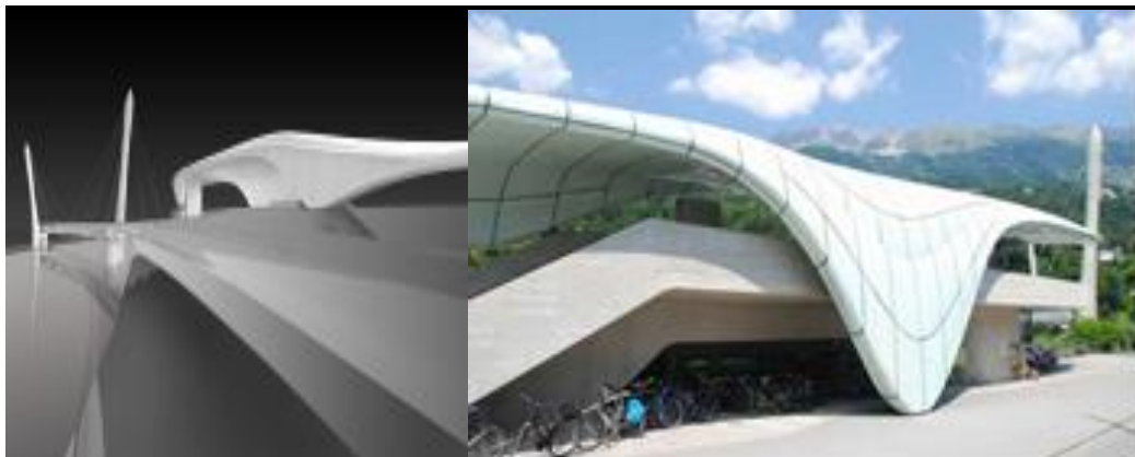
Εικόνα 3.1.7 Φωτογραφία του σταθμού Löwenhouse
