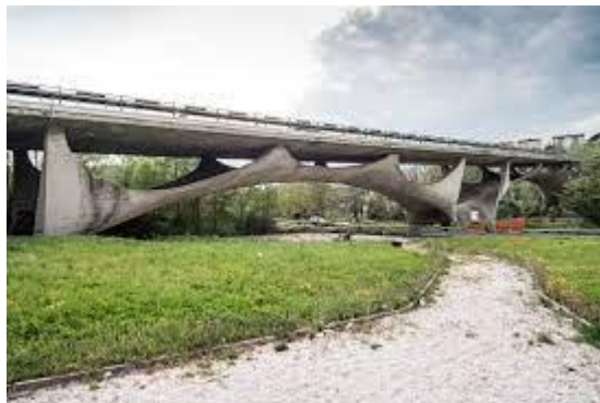
Εικόνα 2.7 Γέφυρα του ποταμού Basento, Ποτένζα, Ιταλία
