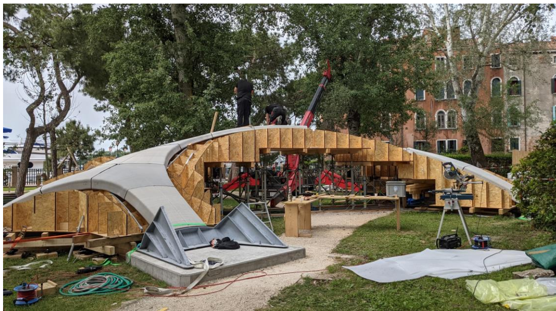
Εικόνα 3.2.14 Στάδια κατασκευής της γέφυρας StriatuS
