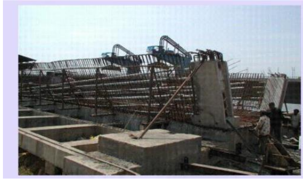
Εικόνα 7: Εσωτερική προένταση σε δομή «κιβωτίου» δοκού ( https://old.amu.ac.in/emp/studym/99992327.pdf ).
