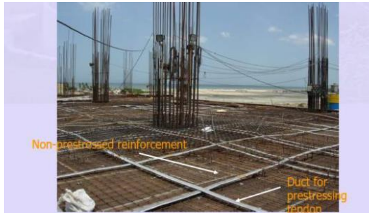
Εικόνα 10: Διαξονική προένταση πλάκας ( https://old.amu.ac.in/emp/studym/99992327.pdf )
