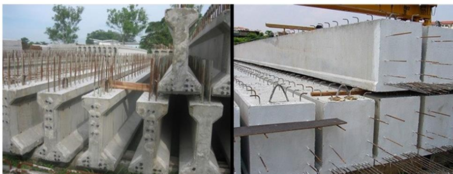
Εικόνα 23: Αποθήκευση δοκών προέντασης.
