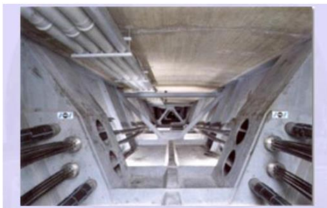
Εικόνα 6: Εξωτερική προένταση κιβωτίου δοκού ( https://old.amu.ac.in/emp/studym/99992327.pdf )
