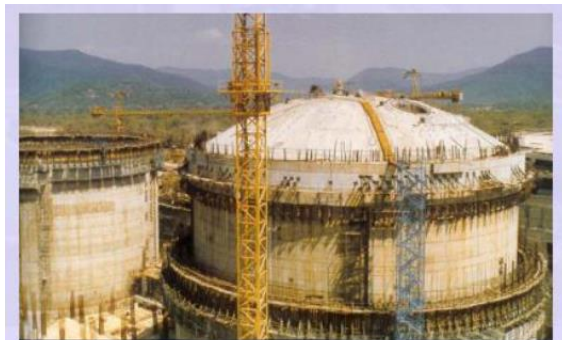
Εικόνα 9: Κυκλικά προεντεταμένη δομή συγκράτησης ( https://old.amu.ac.in/emp/studym/99992327.pdf )
