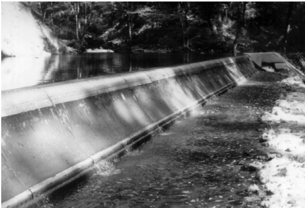
Σχήμα 4.62 Εφαρμογή διάταξης Coanda [Ξ1, Photo 7.17]
