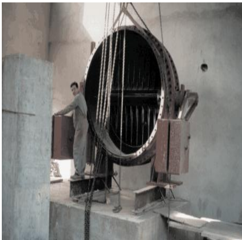
Σχήμα 4.58 Θυρόφραγμα & Βάνα σε σχήμα πεταλούδας. [Ξ1, Figure 5.25 & Photo 5.13]
