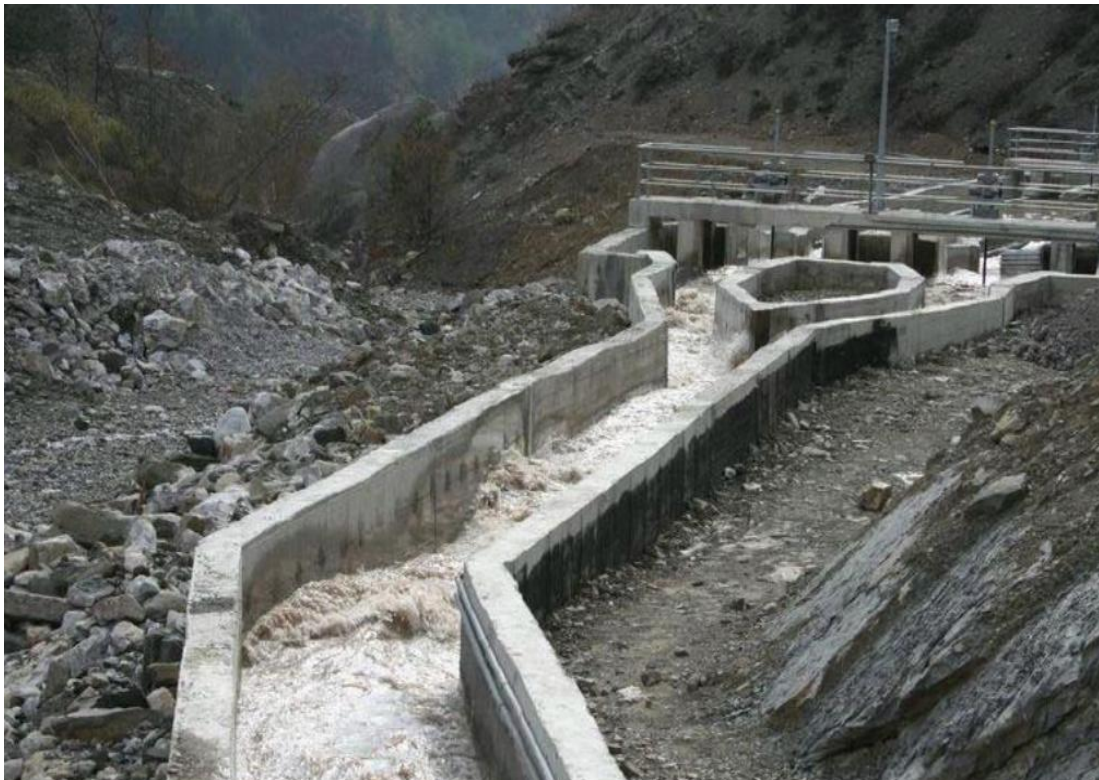
Σχήμα 4.42 Διώρυγα και παγίδα φερτών υλικών μικρού υδροηλεκτρικού σταθμού στο Θερμόρεμα, Σπερχειάδα Φθιώτιδας, Ισχύος 1,95 MW, 2003 [112]
