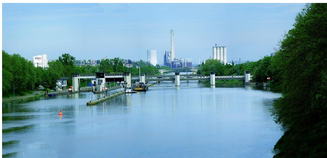
Σχήμα 7.3 Σταθμός Παραγωγής Neckar [I21]
