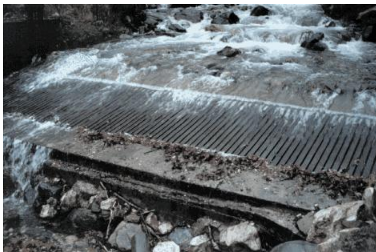
Σχήμα 4.33 Ορεινή υδροληψία με εσχάρα[Ξ1, Photo 5.8]
