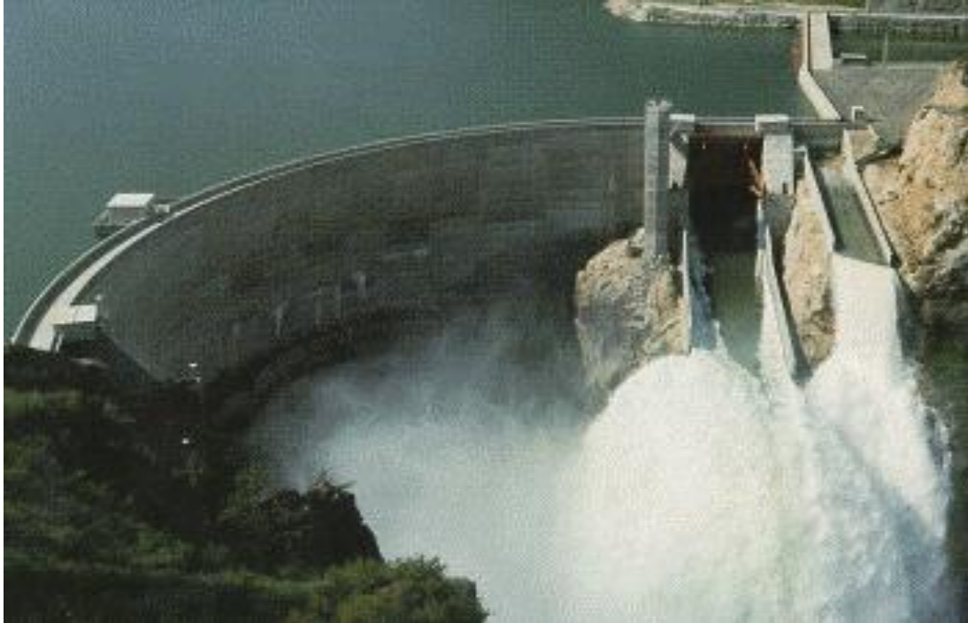
Σχήμα 4.8 Τοξωτό φράγμα. [Ξ1, Σχήμα 5.2]
