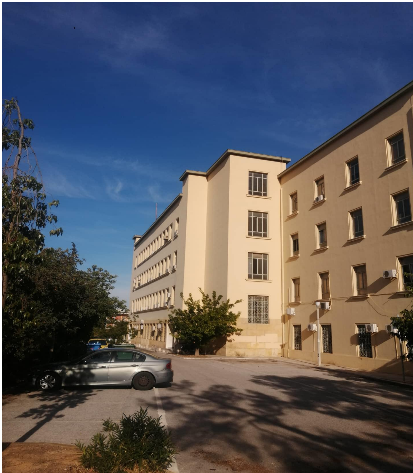
Κτήριο Αντοχής Υλικών Εθνικό Μετσόβιο Πολυτεχνείο
