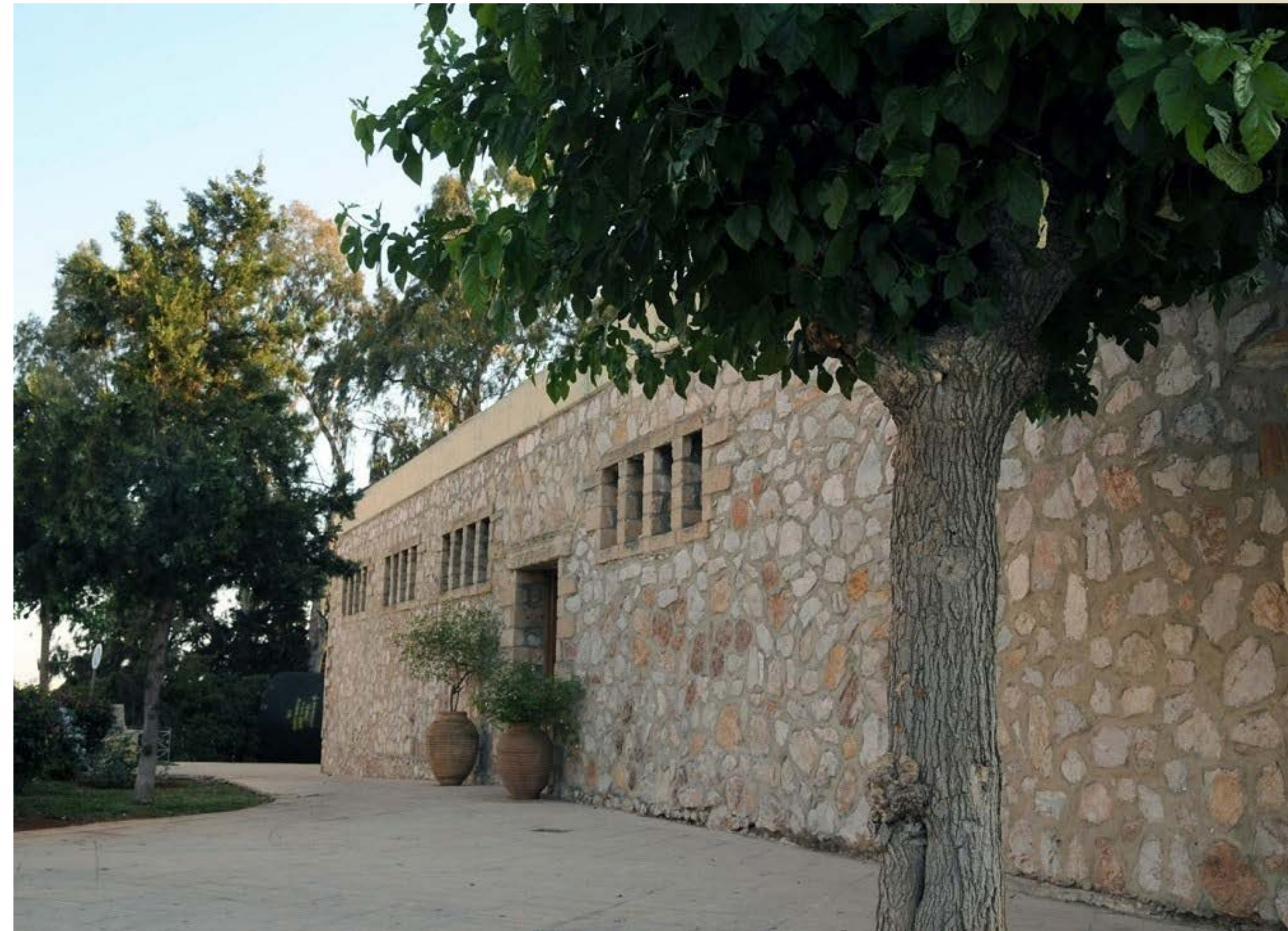
Εικόνα 37 : Η ανατολική όψη του κτιρίου.
