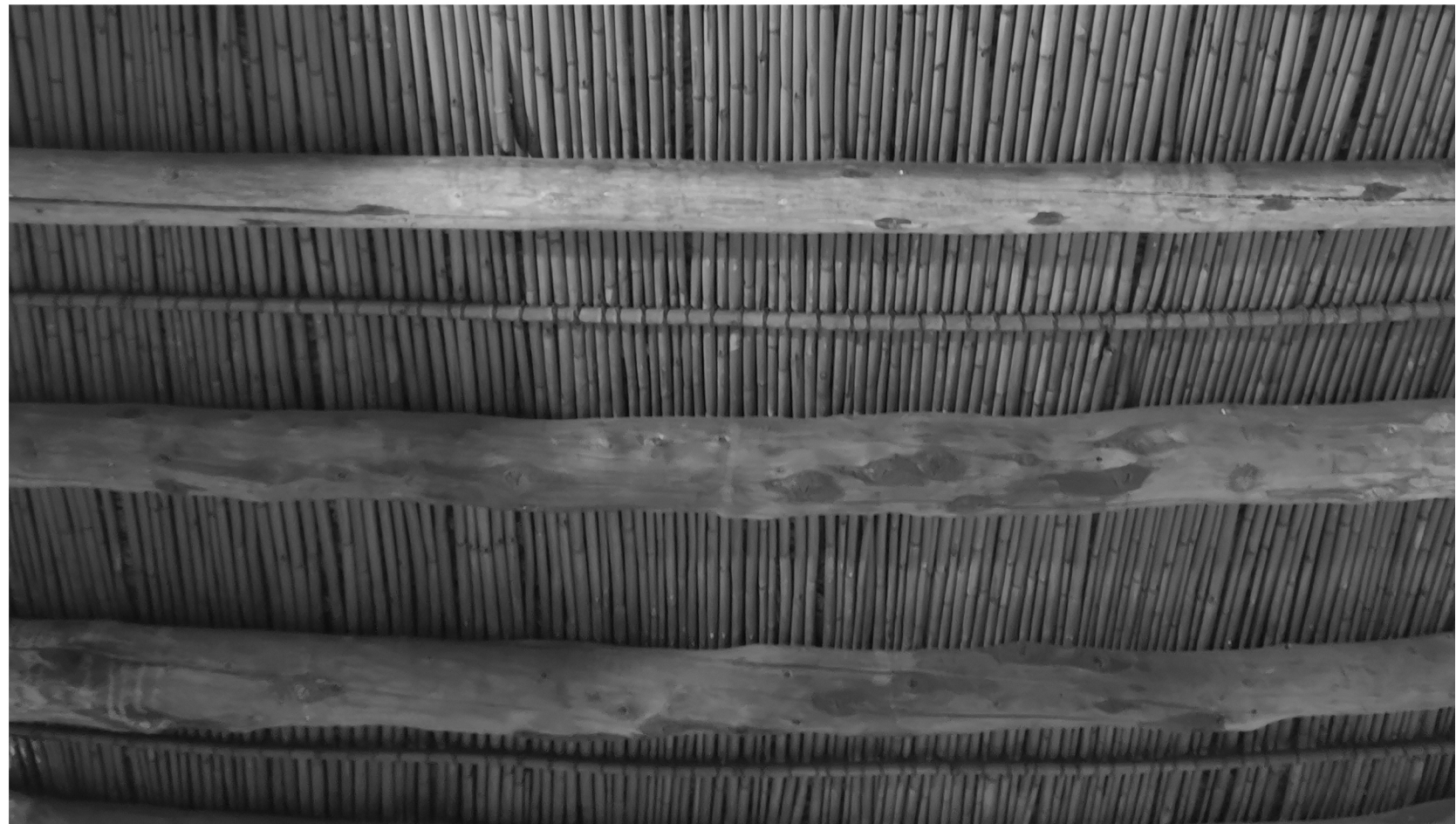
Πτυχές από τον εσωτερικό χώρο του κτιρίου.
