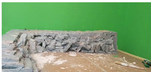
Εικόνα 22 Η τελική προσπάθεια κατασκευής του βράχου.
