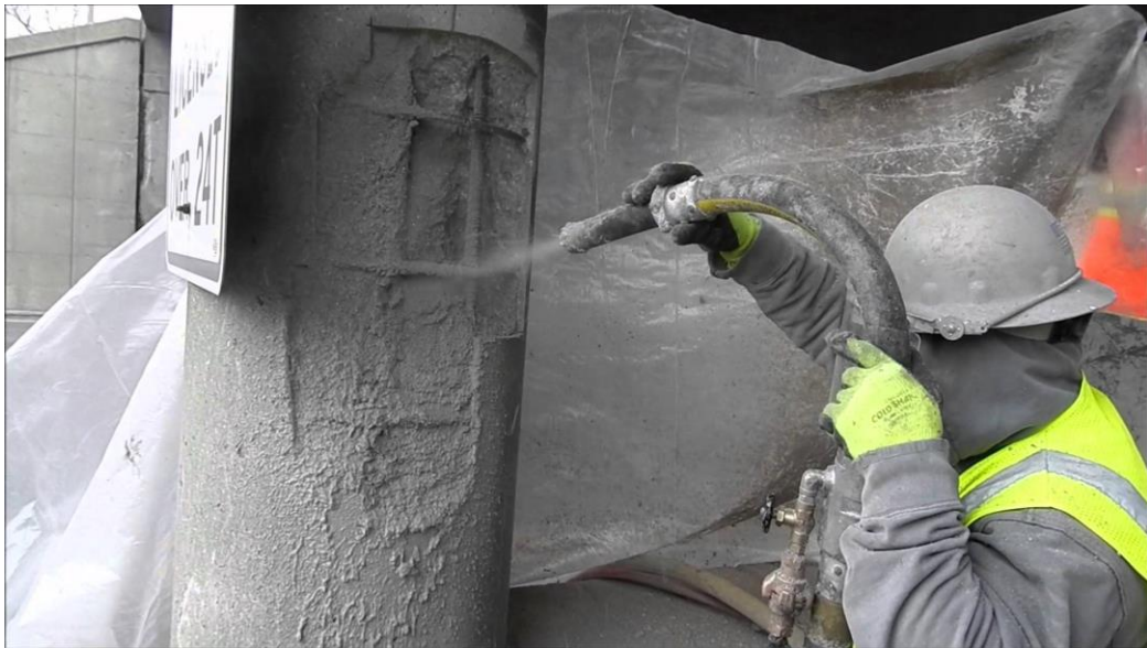
Σχήμα 4.6 Κατά την διάρκεια του ψεκασμού
