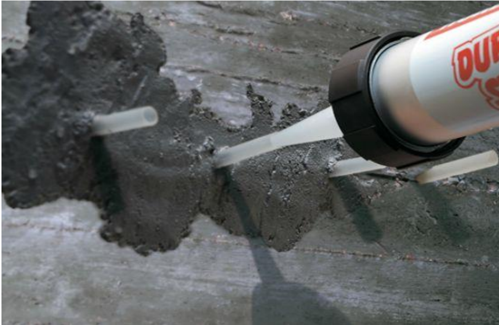
Σχήμα 8.19 Εφαρμογή ρητινενέσεων
