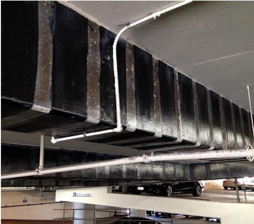
Σχήμα 4.26 Ενίσχυση δοκαριών με FRP s
