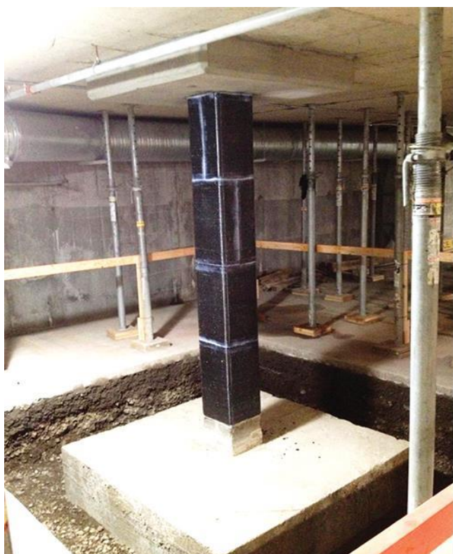
Σχήμα 4.25 Επίσκεψη υποστυλώματος με FRP s
