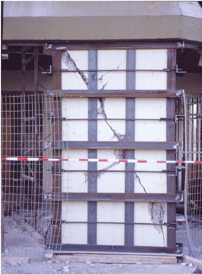
Σχήμα 5.8 Επέμβαση με μεταλλικό κλωβό για προσωρινή ανάληψη κατακόρυφων φορτίων
