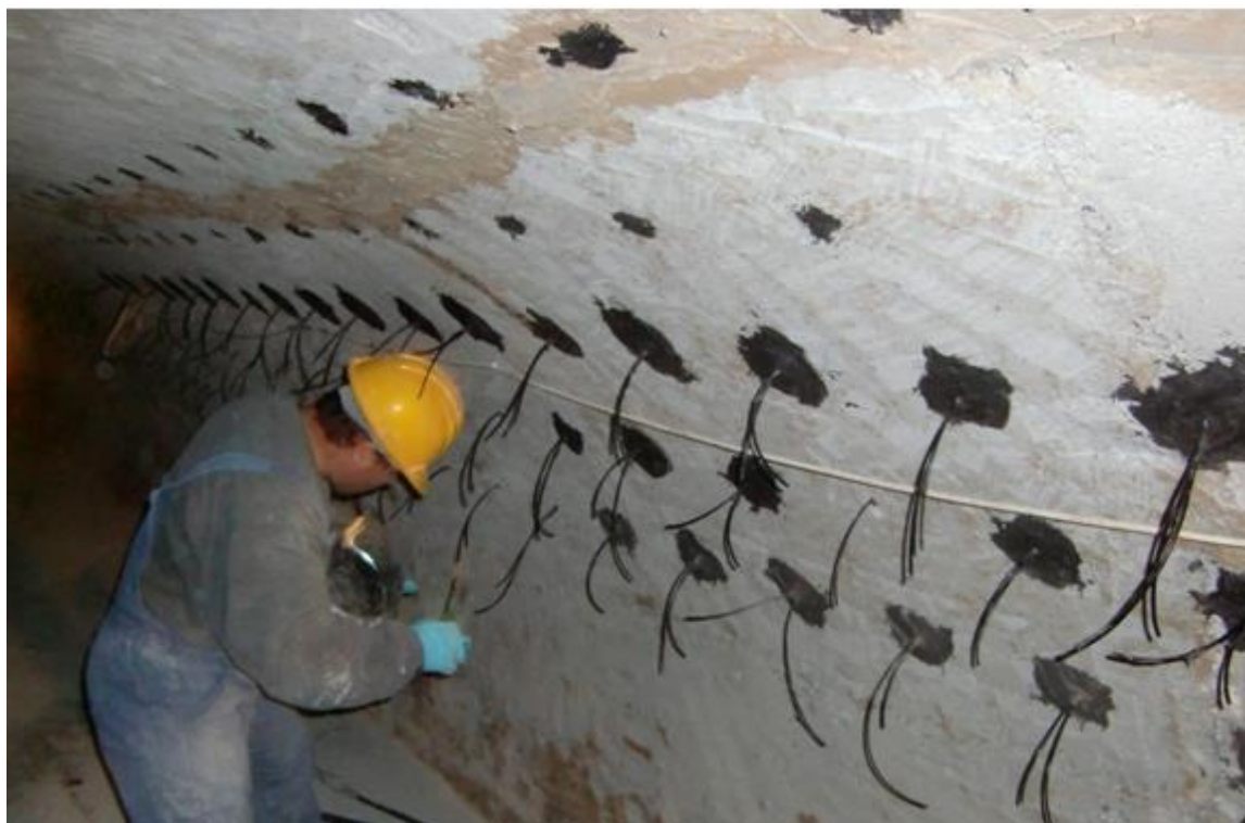
Σχήμα 4.34 Κατασκευή και τοποθέτηση ριζοπλισμών
