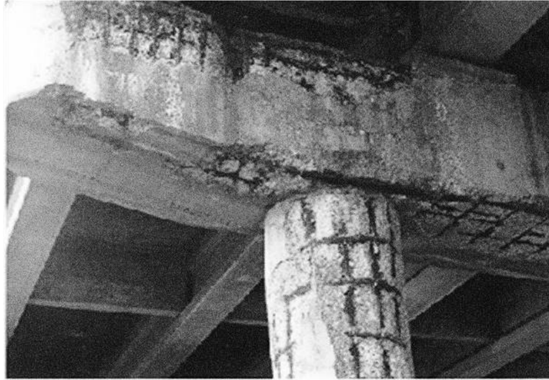
Εικόνα 3.2 Ομοιόμορφη διάβρωση (10).
