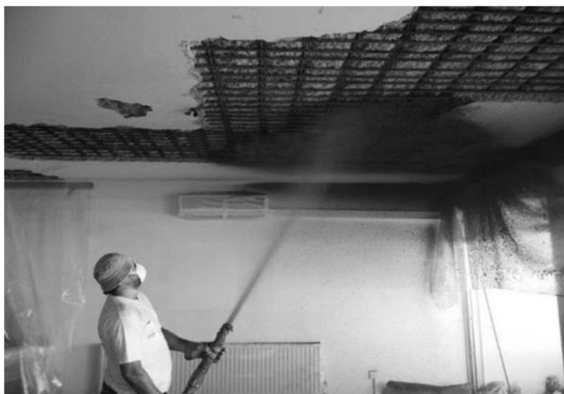
Εικόνα 5.2 Τοποθέτηση προστατευτικού επιστρώματος (10).
