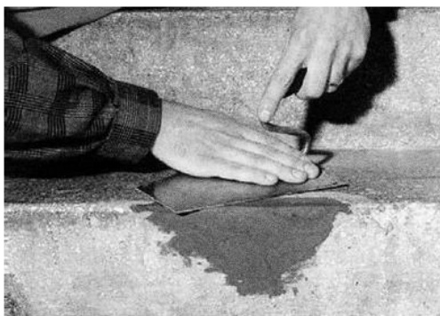
Εικόνα 2.7 Πλήρωση κενού (Φαρδής,2005).
