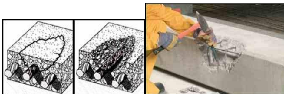
Εικόνα 2.3 Διαδικασία αναστολής ενανθράκωσης σε ήδη ενανθρακωμένο δοκίμιο από Μπετόν (13).
