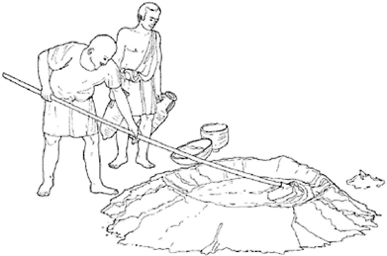
Εικ.5.5. Προετοιμασία ασβεστοκονιάματος (Adam 1994)
