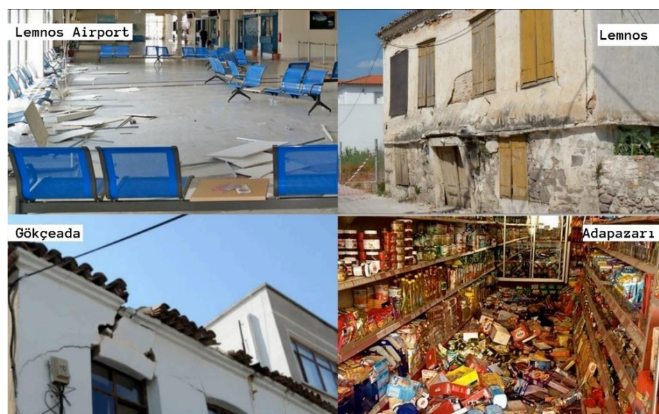
Εικόνα 15: Ζημιές που προκλήθηκαν από το σεισμό σε 3 περιοχές (Πηγή φωτογραφιών: KANDiLi Observatory & Earthquake Research Institute (Earthquake Report) )
