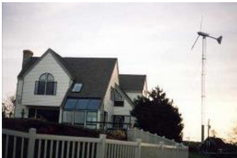
Εικ.43-Μικρή ανεμογεννήτρια σε αυλή κατοικίας
