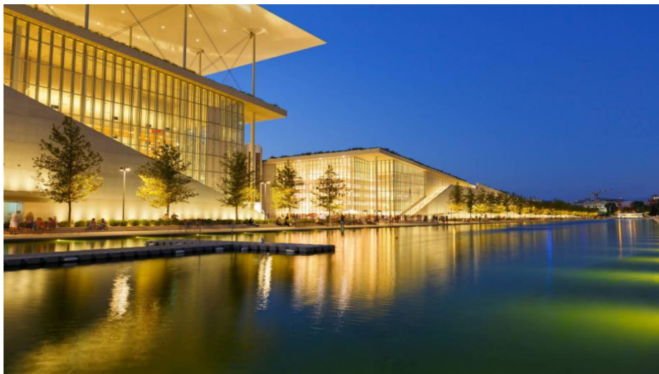
Εικ.32-Μεγάλες επιφάνειες καλυμμένες από νερό σχεδιάζονται σε πολλά σύγχρονα κτήρια για εξατμιστικό δροσισμό
