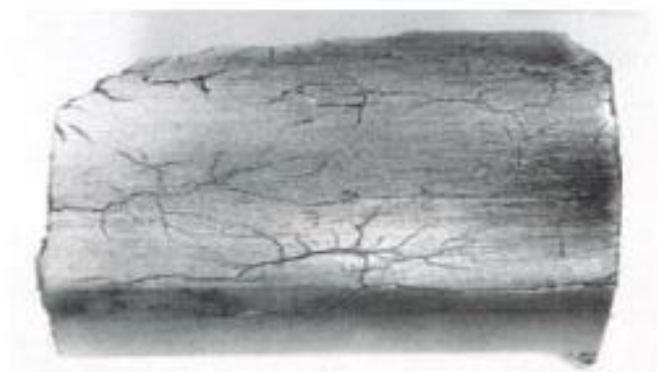
Εικ. 2.18: Αποικία ρωγμών από μηχανική διάβρωση στην εξωτερική επιφάνεια σωλήνα από ανοξειδωτο χάλυβα [23]
