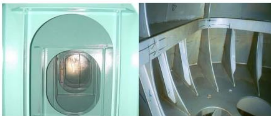
Εικ. 3.2: Δεξαμενή πλοίου μετά την εφαρμογή επίστρωσης[26]
