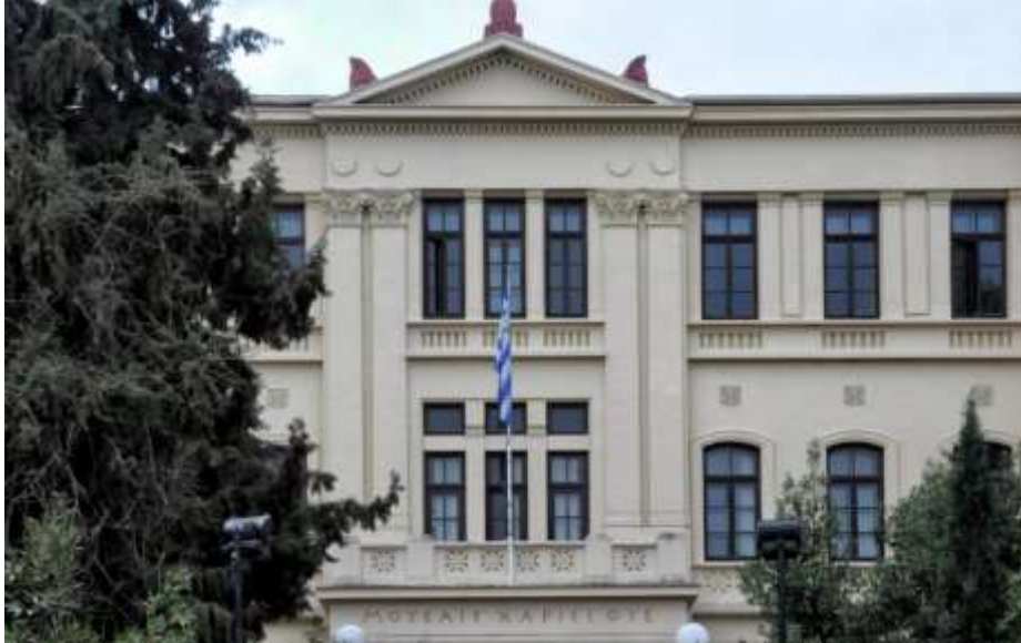
Εικόνα 19, κτίριο παλαιάς Φιλοσοφικής σχολής Θεσσαλονίκη,
