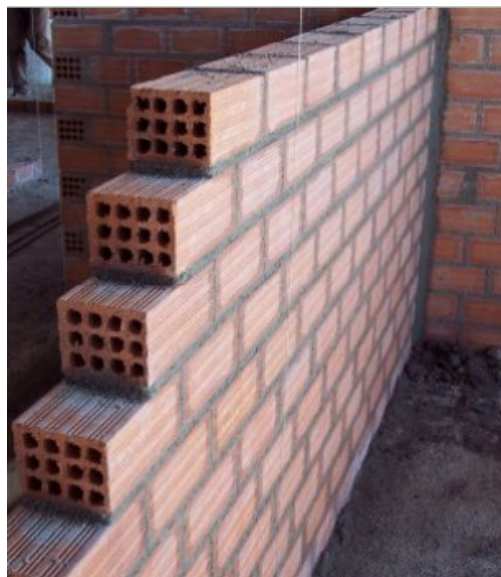
Εικόνα 24: Δρομική τοιχοποιία από δωδεκάοπτα τούβλα.
