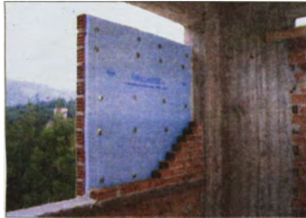
Εικόνα 28: Κατασκευή εξωτερικού τοίχου πλήρωσης με θερμομόνωση στο εσωτερικό του.
