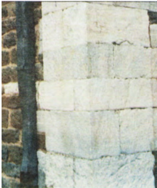
Εικόνα 16: Κατασκευή με λαξευτή λιθοδομή
