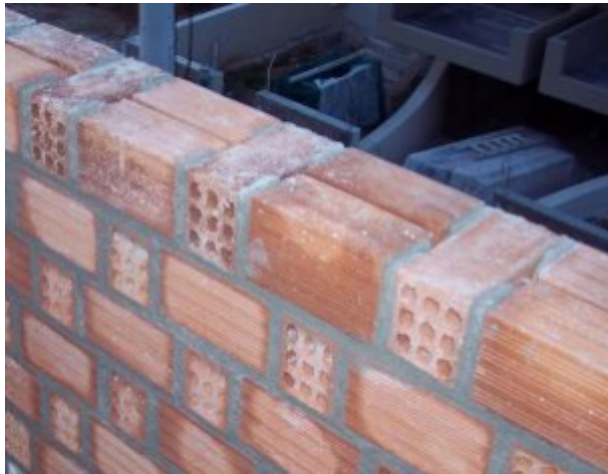
Εικόνα 25: Μπατική τοιχοποιία από εννιάοπτα τούβλα
