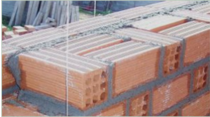
Εικόνα 26: Υπερμαπτική τοιχοποιία από εννιάοπτα τούβλα
