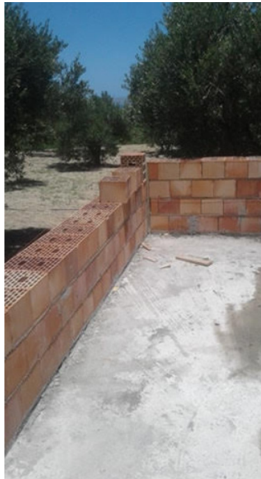
Εικόνα 10: Σύγχρονη κατασκευή διαζωματικής φέρουσας τοιχοποιίας
