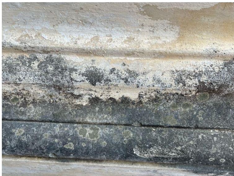
Εικόνα 34: Λεπτομέρεια της βάσης του πόδιου όπου παρατηρείται ανάπτυξη λειχήνων (πλάγια- αριστερή όψη).
