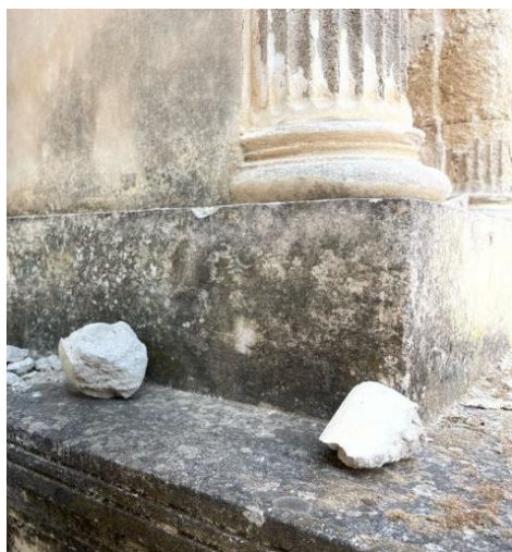
Εικόνα 35: Ανάπτυξη βρύων κατά μήκος της βάσης όπου εδράζονται οι Ιωνικοί ημικίονες (πλάγια- αριστερή όψη).
