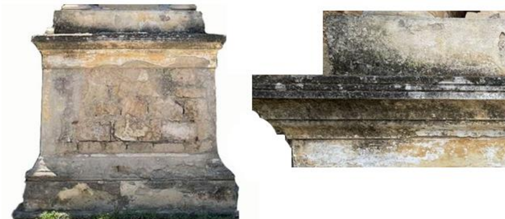
Εικόνα 25: Χρωματική αλλοίωση από βιολογικές και περιβαλλοντικές επικαθίσεις στο πόδιο του ναΐσκου.
