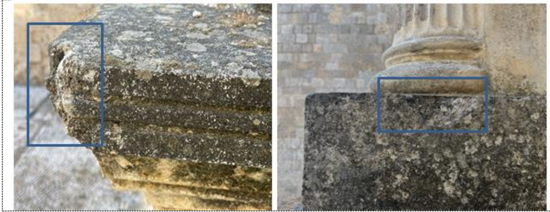
Εικόνα 36: Απώλεια υλικού από τη βάση όπου εδράζονται οι Ιωνικοί ημικίονες (πλάγια από τα δεξιά όψη).
