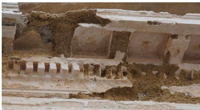
Εικόνα 14: Λεπτομέρεια της επίστεψης όπου διακρίνονται τα υλικά δόμησης.
