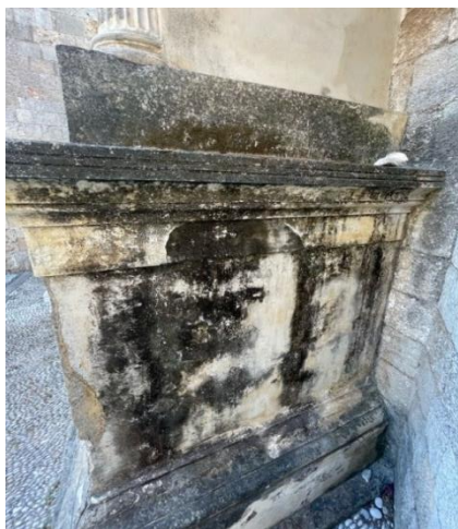
Εικόνα 39: Πλάγια από τα δεξιά όψη του πόδιου, όπου παρατηρείται χρωματική αλλοίωση από βιολογικές και περιβαλλοντικές επικαθίσεις.
