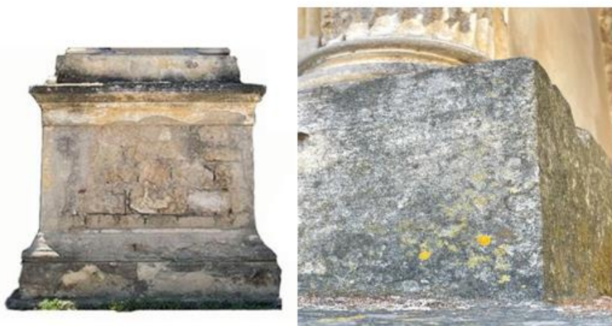
Εικόνα 26: Ανάπτυξη λειχήνων στο πόδιο και στη βάση όπου εδράζονται οι Ιωνικοί ημικίονες.
