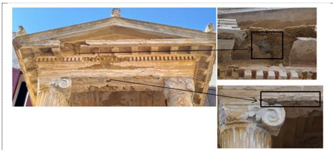
Εικόνα 22: Ύχνη από συμπληρώσεις στον θριγκό και το επιστύλιο του ναΐσκου.
