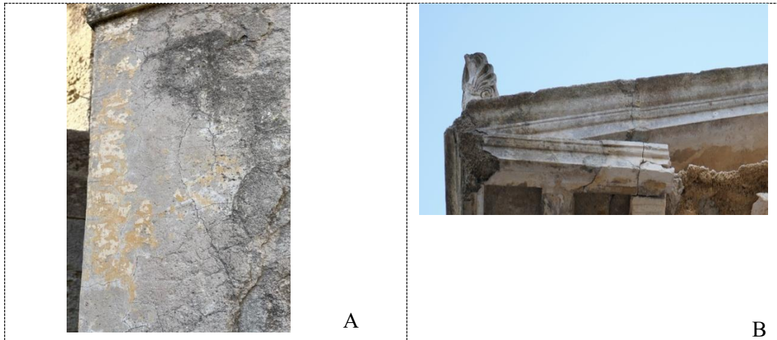
Εικόνα 23: Α: Πλέγμα ρωγμών στο πόδιο, Β: Κάθετες ρωγμές στο αέτωμα.
