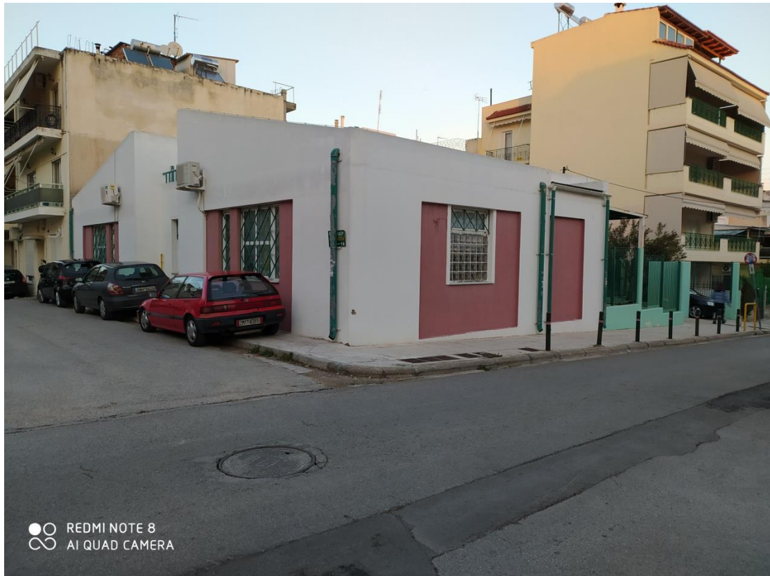
Εικόνα 4.2: Νότια και δυτική όψη κτιρίου του νηπιαγωγείου.
