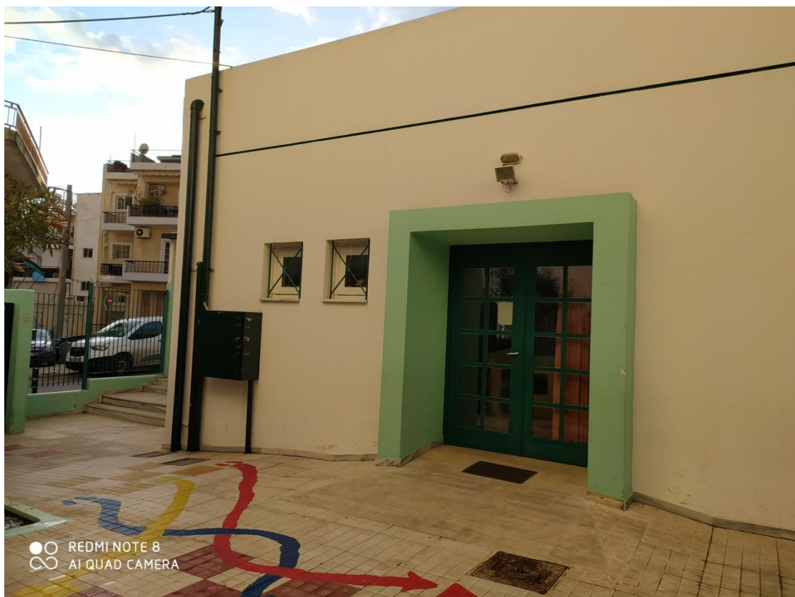
Εικόνα 4.4: Είσοδος κτιρίου από τον προαύλιο χώρο στην ανατολική του όψη.
