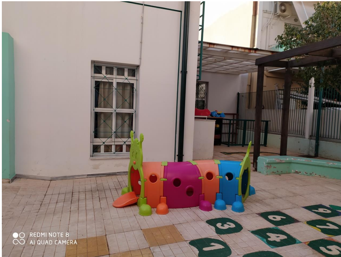
Εικόνα 4.5: Τμήμα της ανατολικής όψης του κτιρίου από τον προαύλιο χώρο.
