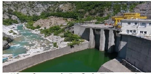
Υδροηλεκτρικός Σταθμός Παραγωγής
