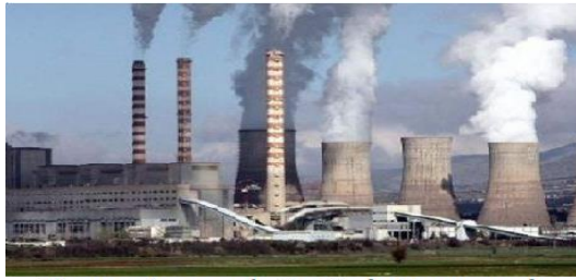
Θερμοηλεκτρικός Σταθμός Παραγωγής
