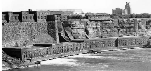
Καταρράκτες Νιαγάρα Υδροηλεκτρικός Σταθμός
