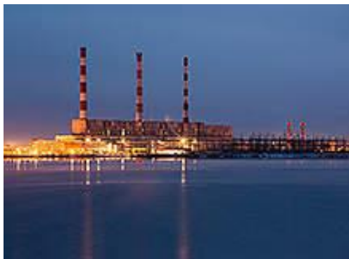
Εικόνα 4.1. Ο θερμοηλεκτρικός σταθμός Surgutskaya GRES-2, Russia.
