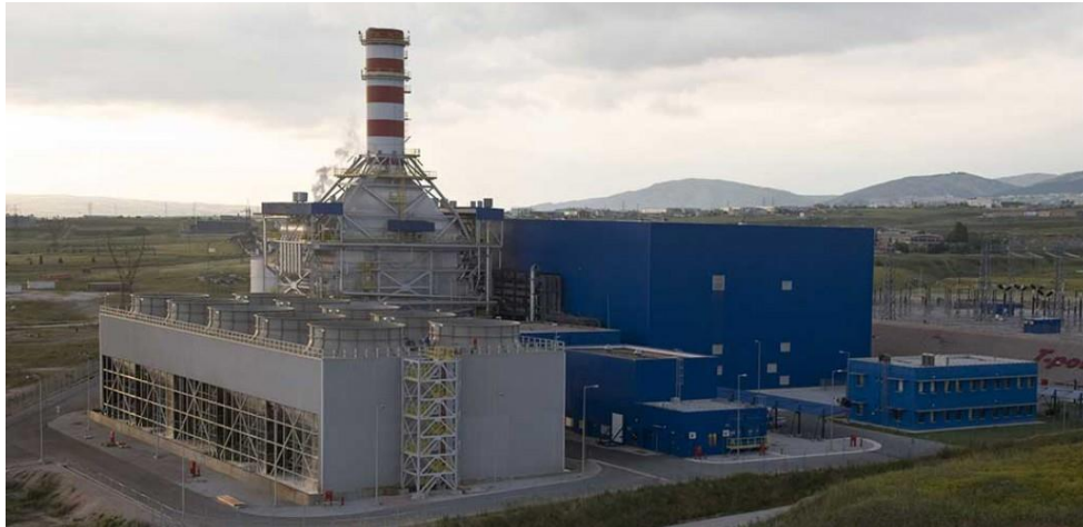
Εικόνα 3. Η υπάρχουσα μονάδα παραγωγής ηλεκτρικής ενέργειας της ELPEDISON στη Θεσσαλονίκη 32
