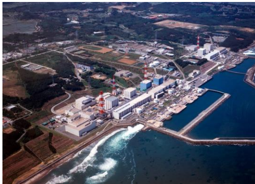
Εικόνα 4.6. Ο θερμοηλεκτρικός σταθμός Φουκουσίμα, Ιαπωνία.
