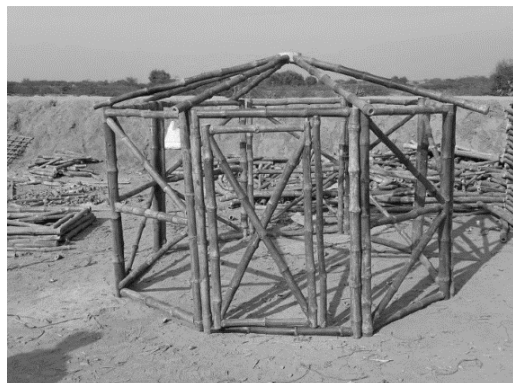
Εικόνα 7: Κατασκευή προκατασκευασμένων πράσινων καταφυγίων στο Chitral, Δεκέμβριος 2015 11
