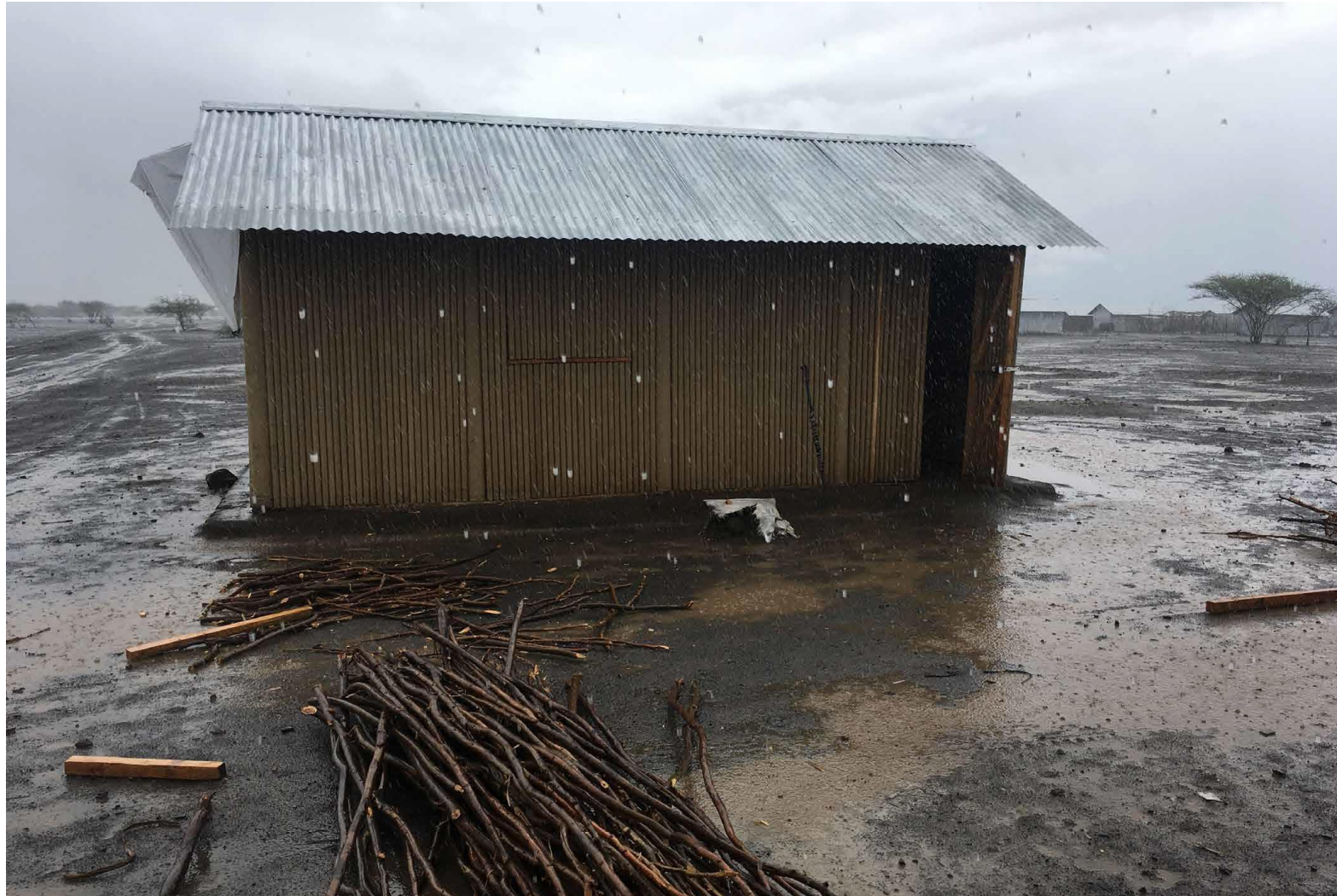
Εικόνα 60: Κατασκευή Τύπου Α υπό βροχή
