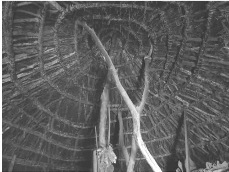
Εικόνα 54: Μέσα σε ένα Luak. Ένα υπερυψωμένο κρεβάτι για ύπνο με βοοειδή από κάτω, δεμένο σε μανταλάκια στο έδαφος. Η δομή είναι κατασκευασμένη από 15-20 πόλους, ανάλογα με το μέγεθος του Luak. Φωτογραφίες από την Anita Corluka
