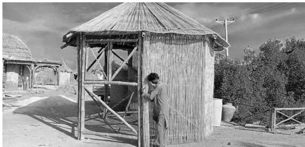
Εικόνα 8: Κατασκευή πετασμάτων καταφυγίων
