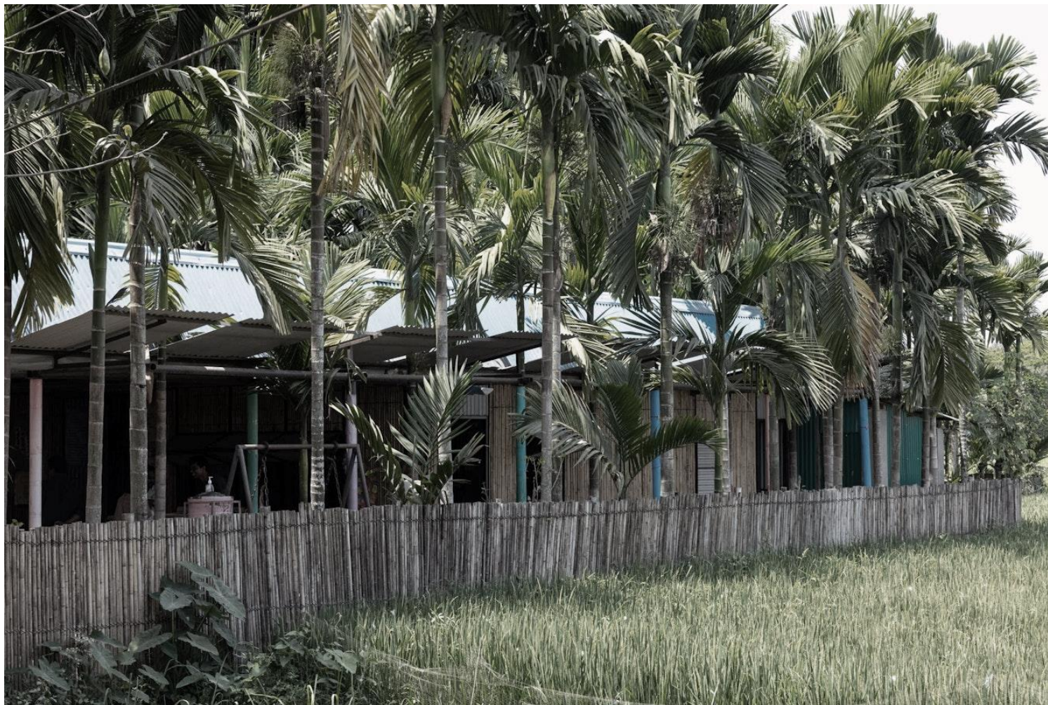
Εικόνα 30: Εξωτερική όψη Κοινοτικού Κέντρου
