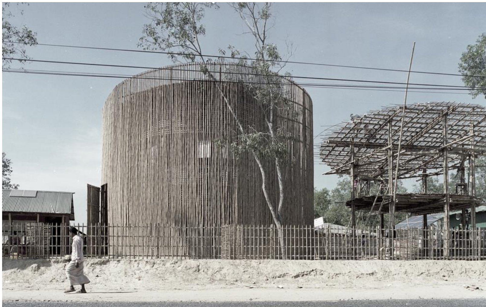
Εικόνα 32: Εξωτερική Όψη Σχολείου
