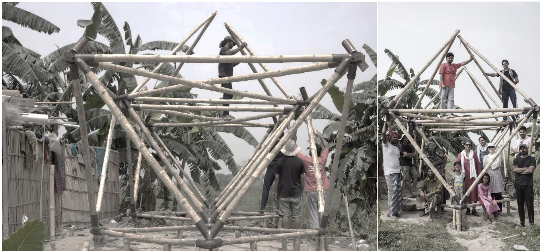
Εικόνα 43: Khudi Bari Κατασκευή φέροντα οργανισμού
