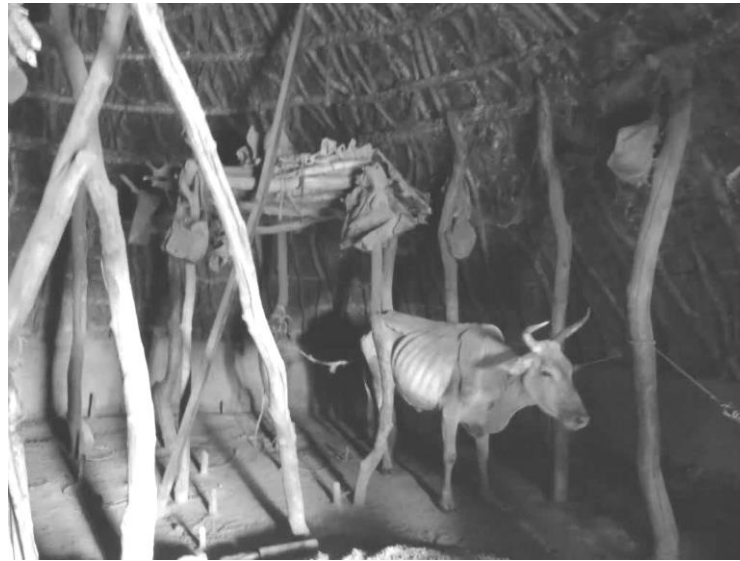
Εικόνα 54: Μέσα σε ένα Luak. Ένα υπερυψωμένο κρεβάτι για ύπνο με βοοειδή από κάτω, δεμένο σε μανταλάκια στο έδαφος. Η δομή είναι κατασκευασμένη από 15-20 πόλους, ανάλογα με το μέγεθος του Luak. Φωτογραφίες από την Anita Corluka
