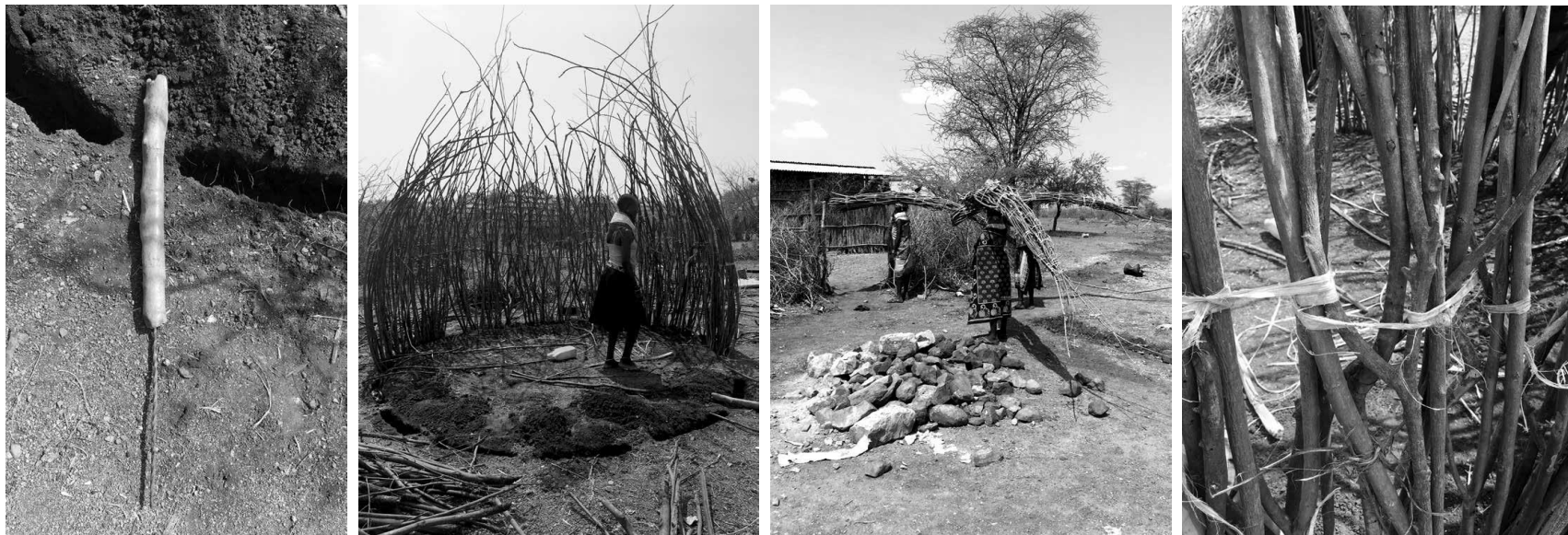
Εικόνα 53: Καλύβα Turkana υπό κατασκευή: Οι εικόνες από αριστερά στα δεξιά
