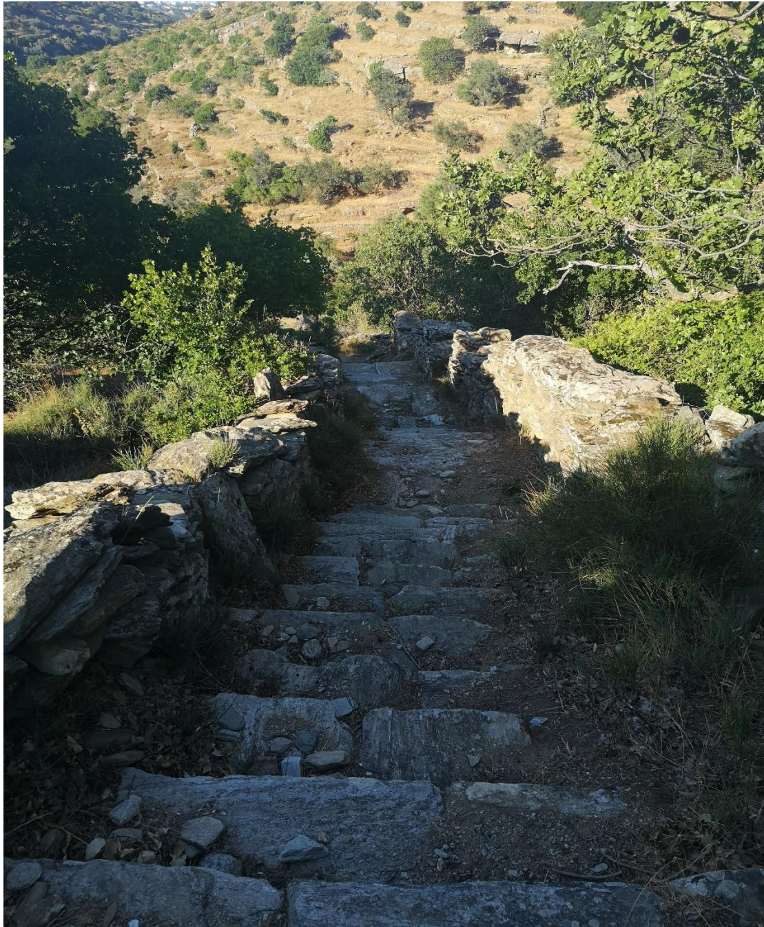
Εικόνα 6.30: Κλιμακωτό μονοπάτι που οδηγεί στο γεφύρι Στοιχειωμένης
