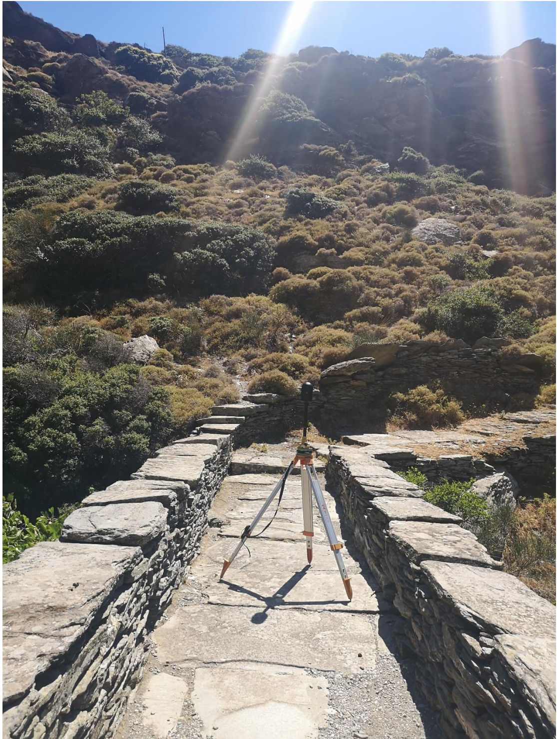
Εικόνα 6.7: Στάση στο κέντρο του καταστρώματος
