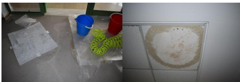
Εικόνα 59: Ο τέταρτος όροφος με τους κουβάδες και το αποτύπωμα της υγρασίας στο ταβάνι
