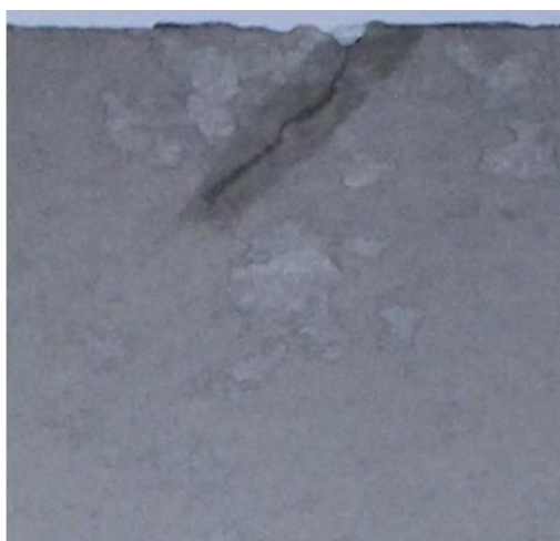
Εικ. 55 Σχέδιο T1, αποκατάσταση απολειών με Gamri και Mitsumata
