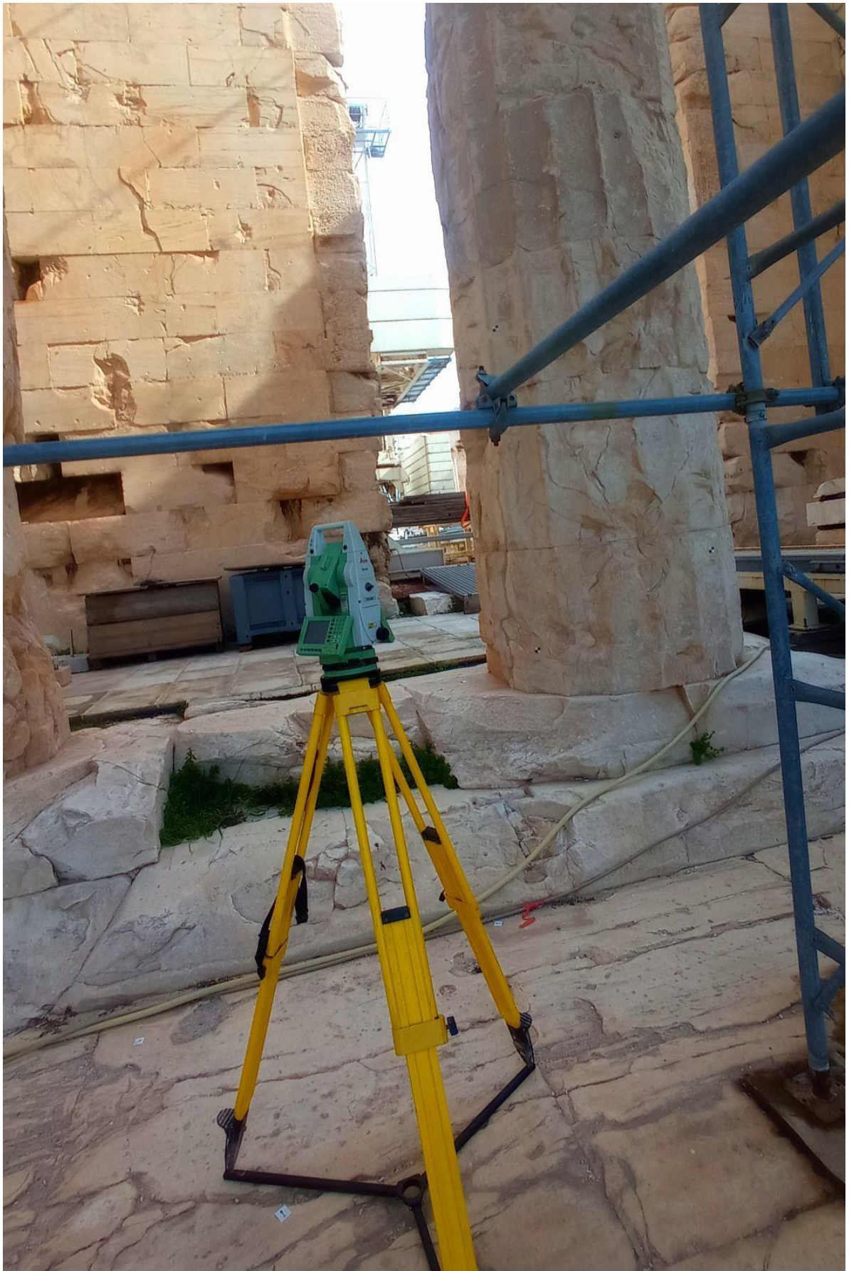
Εικόνα 4.2.3: Μετρήσεις φωτοσταθερών με τον ΟΓΣ Leica TCRP1202 επί της εσωτερικής κιονοστοιχίας της δυτικής πλευράς του Παρθενώνα με σκοπό την αποκατάστασή τους. (Φεβρ. 2022, προσωπικό αρχείο)
