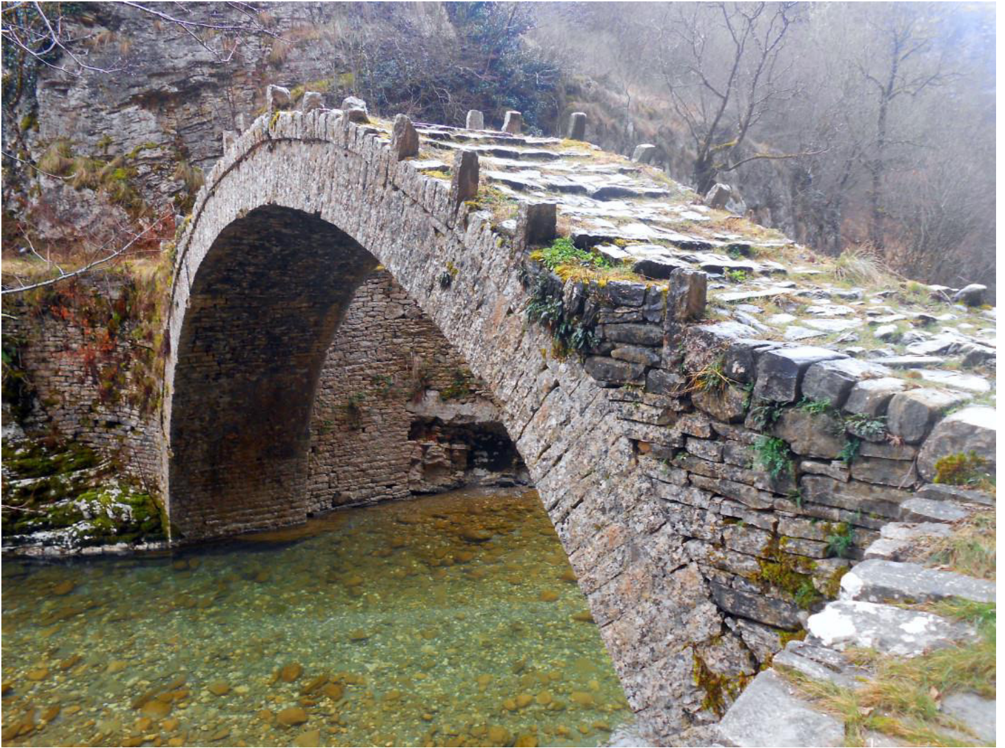
Εικόνα 5.1.3: Το γεφύρι του Κοντοδήμου ή Λαζαρίδη κατασκευής 1753. Διακρίνονται οι γενέσεις επί των οχθών και το καμπύλο κατάστρωμα εξοπλισμένο με αρκάδες ασφαλείας (πηγή: https://hikingexperience.gr/kontodimos-gefyri )
