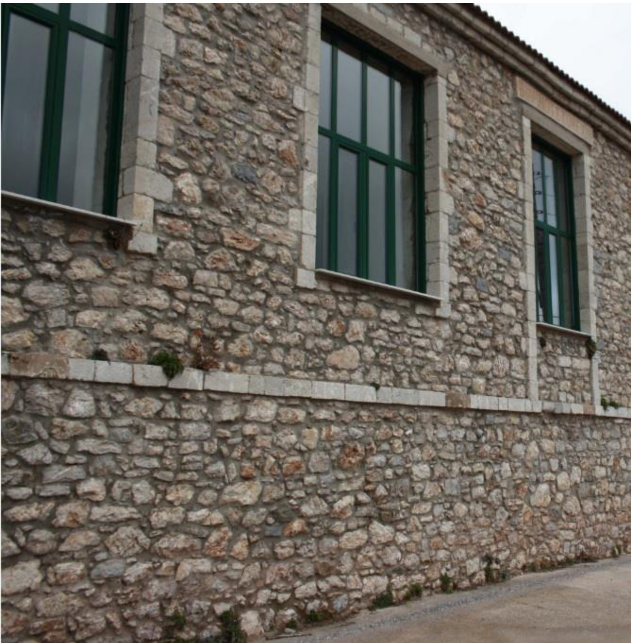
Εικόνα 5.2.3: Ενδεικτική αργολιθοδομή (πηγή: http://5a.arch.ntua.gr/project/4247/5267 )
