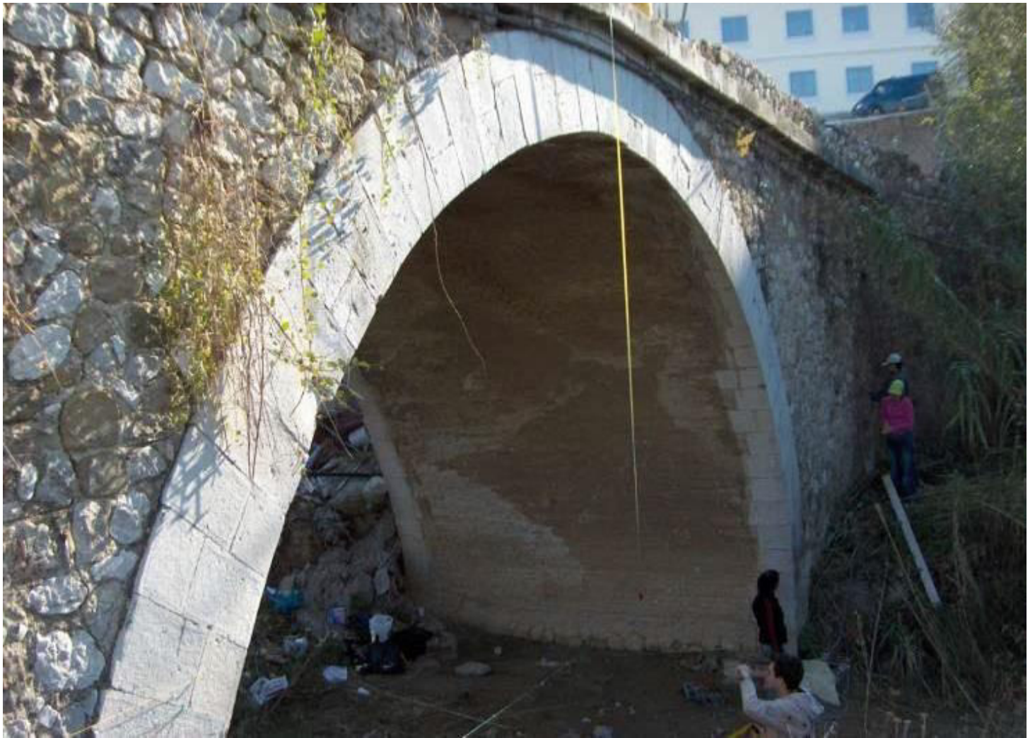
Εικόνα 4.2.2: Χρήση μετροταινίας και νήματος στάθμης. Αποτύπωση Ρωμαϊκής γέφυρας Πατρών
