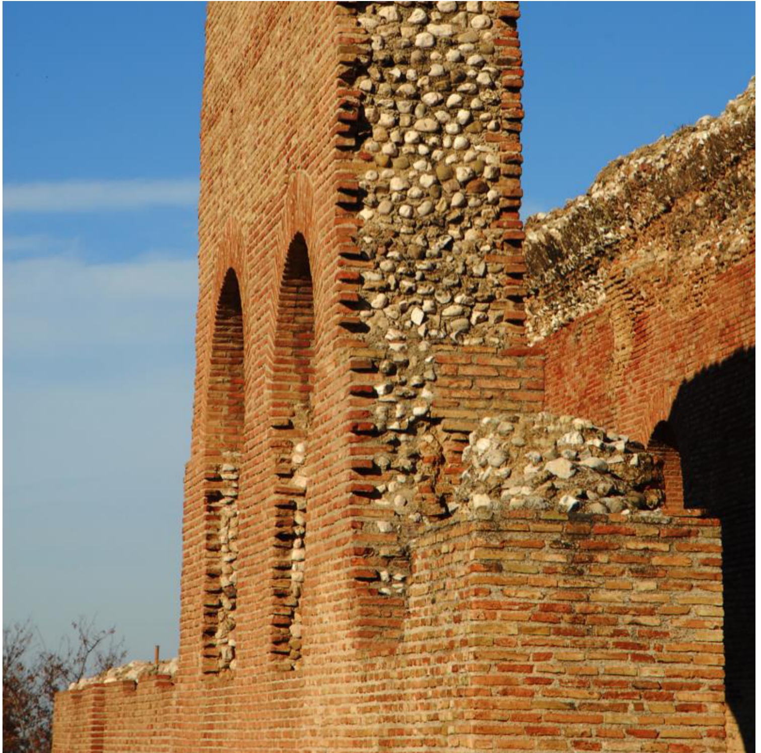
Εικόνα 5.2.6: Κατασκευή χυτής τοιχοποιίας του νότιου τοίχου του Ρωμαϊκού ωδείου της Πάτρας (πηγή: https://explore.patras.gr/listing/romaiiko-odeiogr/ )
