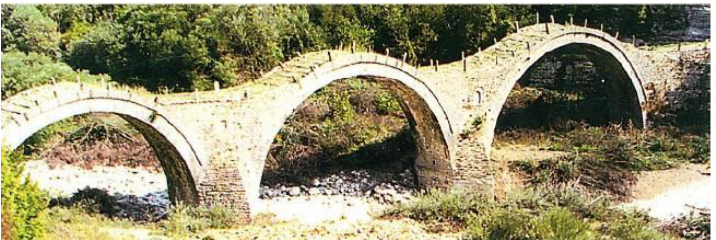
Εικόνα 5.1.11: Το τρίτοξο γεφύρι Πλακίδα στο κεντρικό Ζαγόρι, εφοδιασμένο με προεξοχές επί των βάθρων και αρκάδες επί του καταστρώματος αλλά χωρίς ανακουφιστικά τόξα (πηγή: https://petrinagefiria.com/?q=content/gefyri-plakida )
