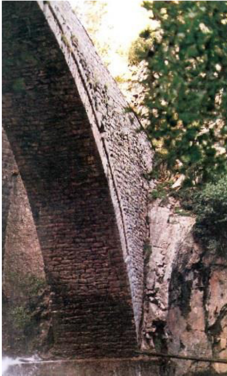
Εικόνα 5.1.8: Γεφύρι Παλιοκαρβάς. Τόξο αρχόμενο πιο ψηλά από τη γένεσή του (Πετρονώτης, 2012)
