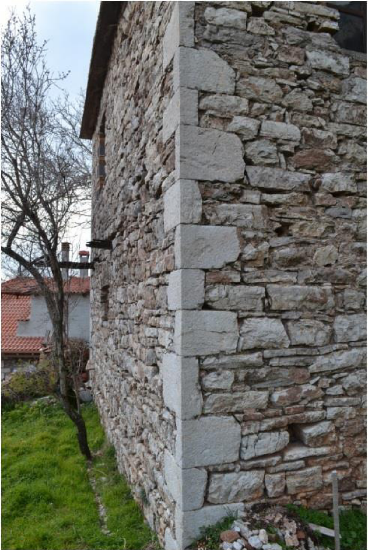
Εικόνα 5.2.9: Η δομή των λαξευμένων γωνιόλιθων (πηγή: http://5a.arch.ntua.gr/project/4245/4707 )
