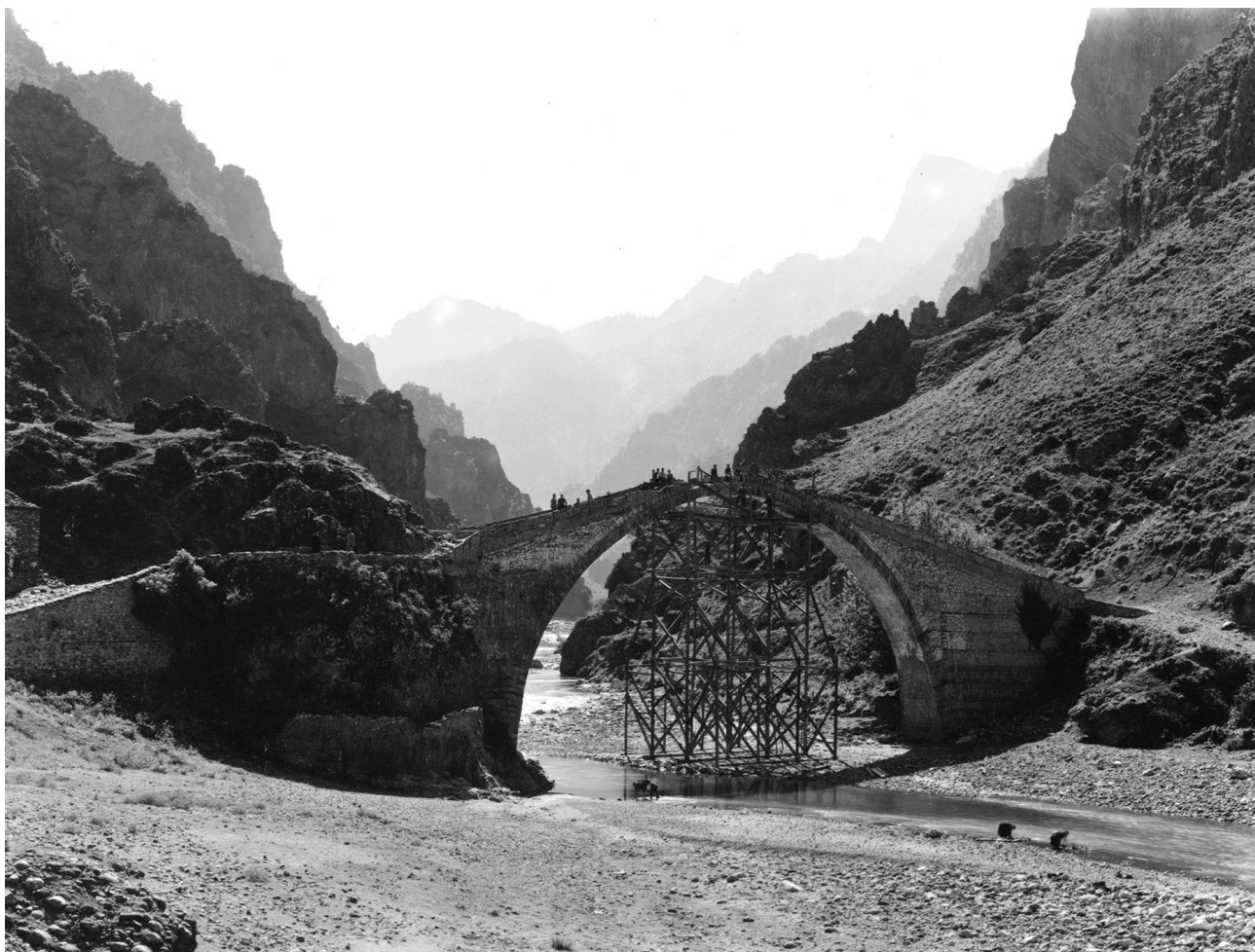
Εικόνα 5.1.4: Ηπειρώτικο μπουλούκι επί τω έργω. Επισκενή γέφυρας Κόνιτσας, Αωός ποταμός, 1913 (πηγή: www.pyrsogianni.gr )
