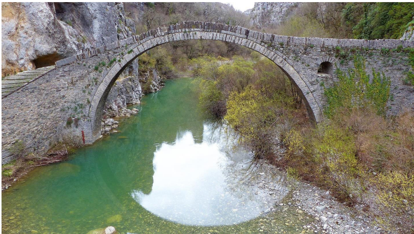
Εικόνα 5.1.5: Μονότοξο Γεφύρι Κοκκόρου, Ζαγοροχώρια. Το Τόξο. Το βασικό κατασκευαστικό χαρακτηριστικό των γεφυριών της εποχής (πηγή: https://hikingexperience.gr/kokkori-gefyri/ )
