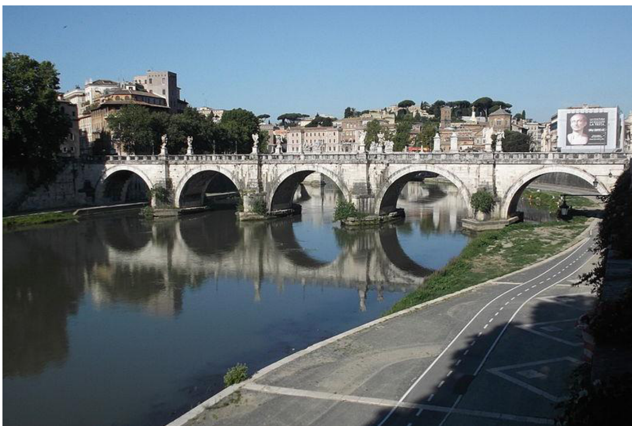
Εικόνα 5.1.1: Γέφυρα του Αγίου Άγγελου, Ποταμός Τίβερης, Ρώμη. Διακρίνονται τα πλήρη ημικυκλικά τόξα (πηγή: https://www.mondovagandosenzameta.it/ponte-sant-angelo-roma )
