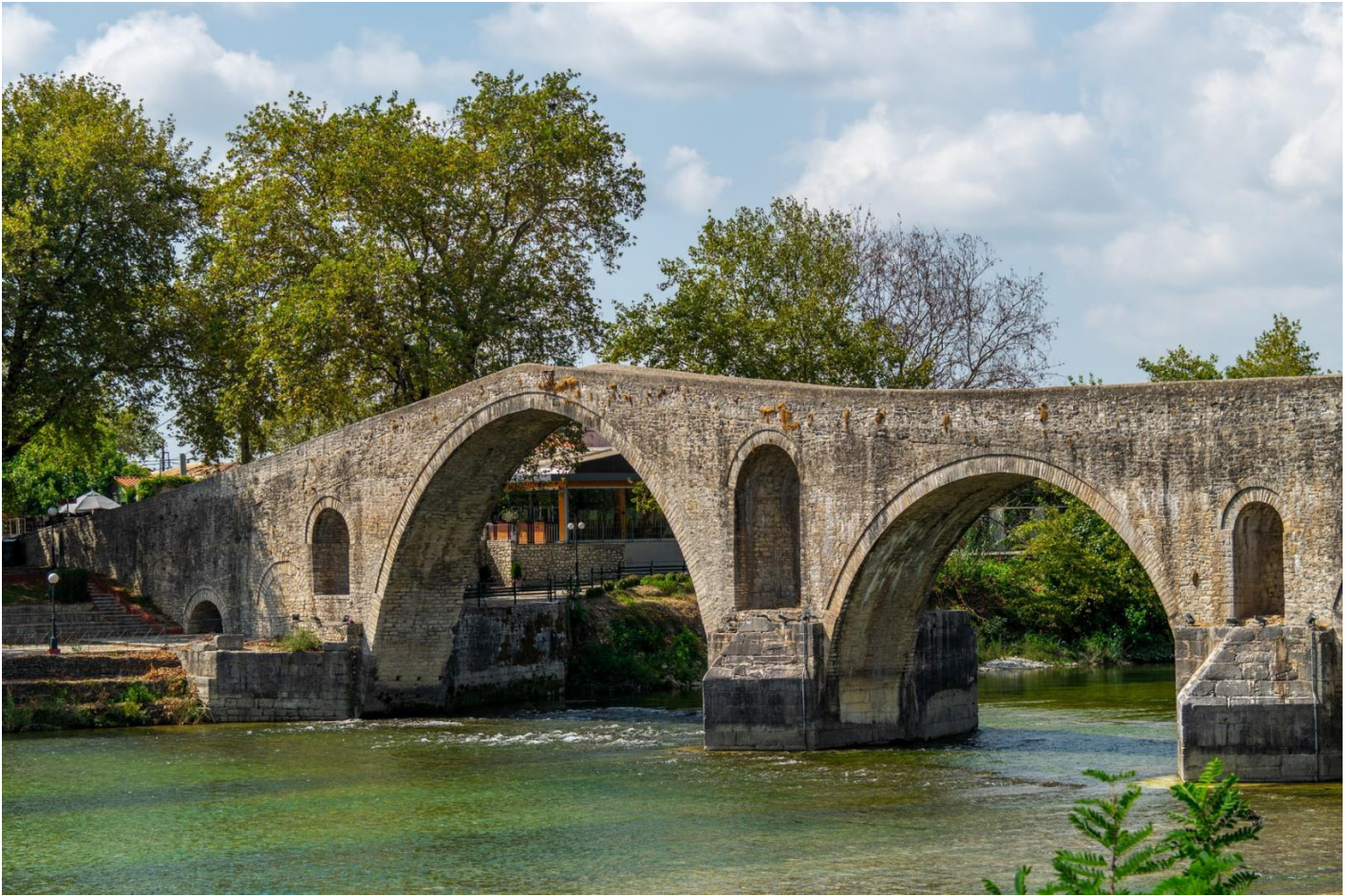
Εικόνα 5.1.10: Το τετράτοξο πέτρινο γεφύρι της Άρτας. Διακρίνονται τα τόξα μεταβλητής ακτίνας, τα ανακουφιστικά τόξα σε κάθε βάθρο και τα βάθρα με τα έμβολά τους (πηγή: https://www.arta.gr/building/to-gefyri-tis-artas/ )
