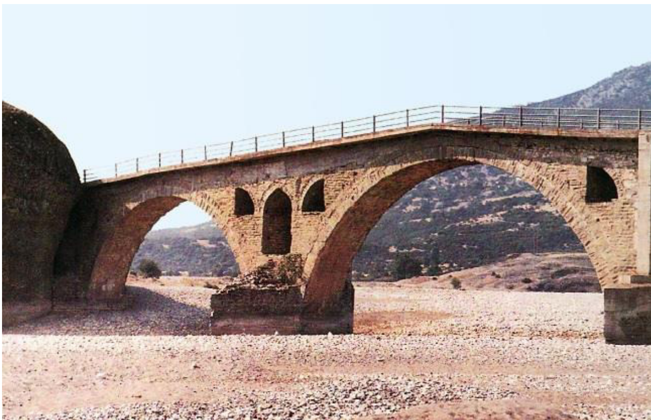
Εικόνα 5.1.9: Γεφύρι Σαρακίνας, Πηνειός ποταμός. Διακρίνονται τα τρία τεταρτοκυκλικά ανακουφιστικά τόξα και το ένα ισλαμίζον (πηγή: Γαλερίδης, Θεσσαλικά Γεφύρια, 1995)
