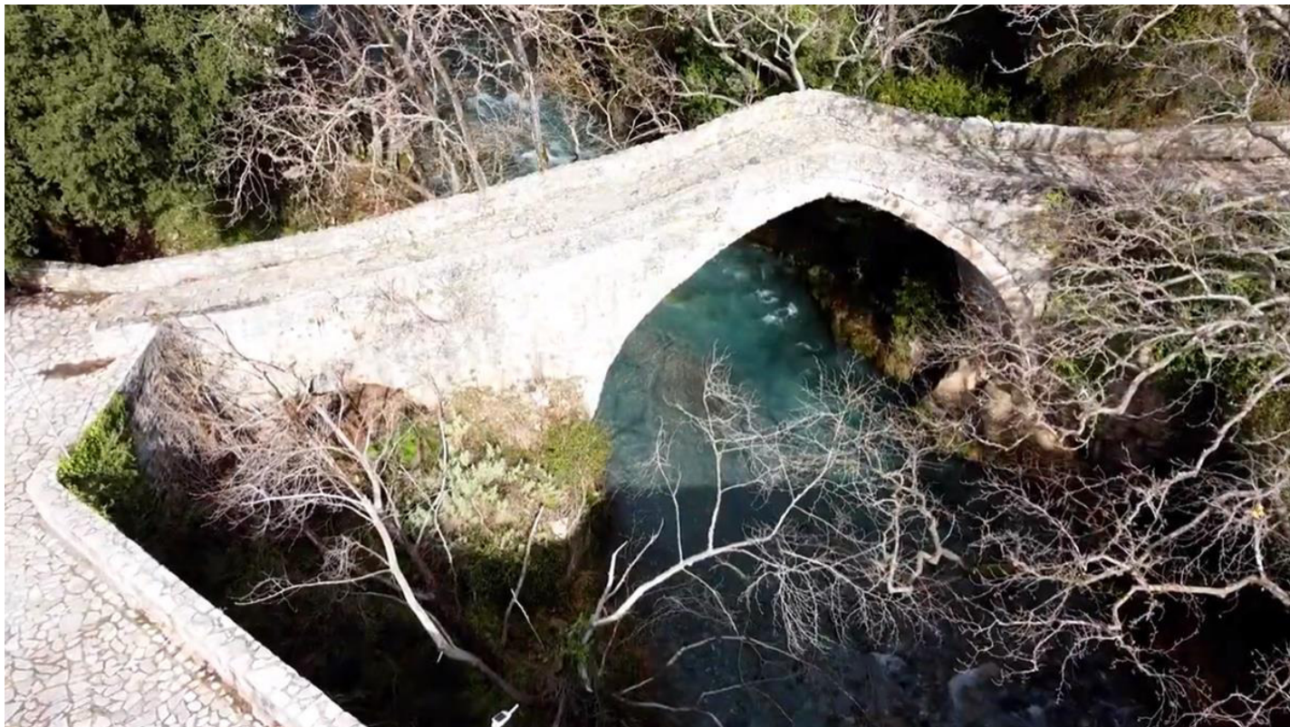
Εικόνα 5.1.6: Μονότοξο γεφύρι του Ατσιλόχου στον ποταμό Λούσιο με το χαρακτηριστικό οξύκορφο ισλαμίζον τόξο
