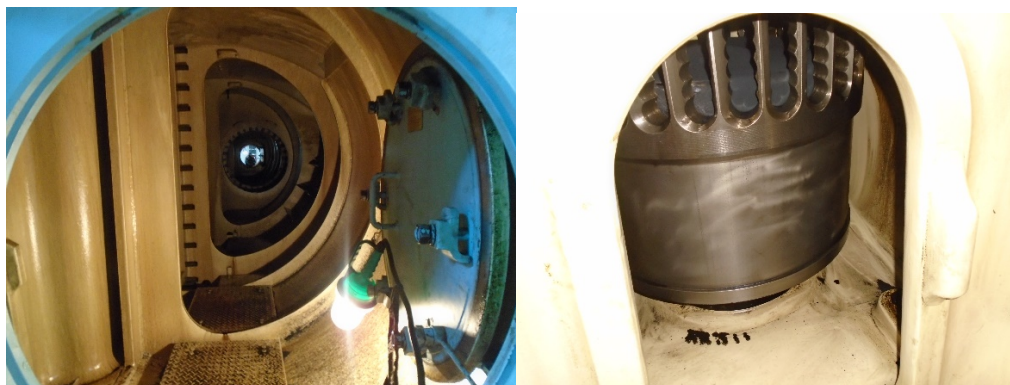
Εικόνα 19. Χώρος Σαρώσεως δίχρονων αργόστροφων πετρελαιομηχανών εμπορικών πλοίων [Πηγή: Προσωπικό αρχείο συγγραφέα]
