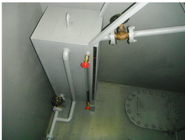
Εικόνα 44. Δεξαμενή συλλογής απωλειών ελαίου συστήματος από τα κιβώτια στεγανότητας (stuffing box)
