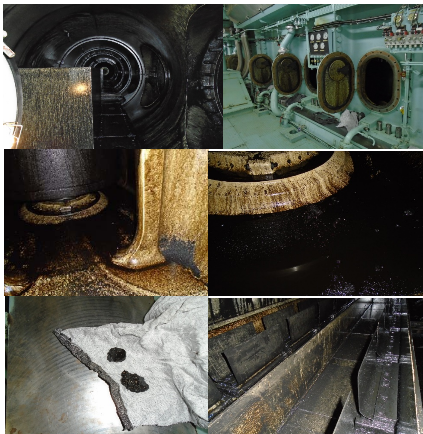
Εικόνα 20. Χώρος (οχετός) αέρα Σαρώσεως πριν τον καθαρισμό του [Πηγή: Προσωπικό αρχείο συγγραφέα]
