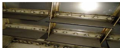
Εικόνα 24. Ανεπίστροφα πτερύγια (non return flap valves)
