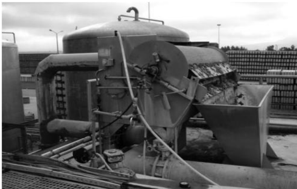
ΕΙΚΟΝΑ 3. Εσχάρα τύπου κυλινδρικού τυμπάνου ΠΗΓΗ Athenianbrewery.gr
