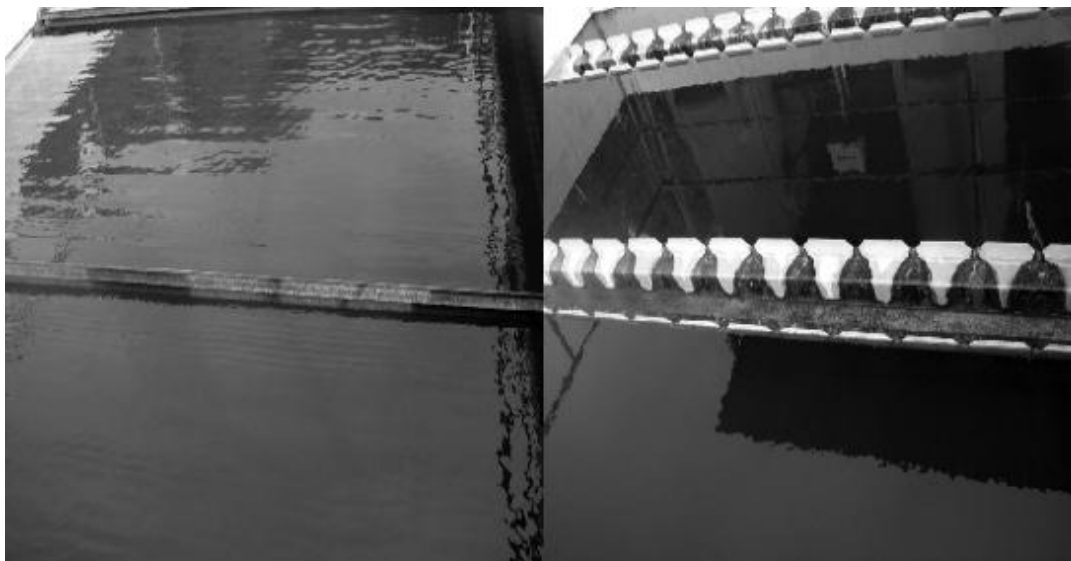
ΕΙΚΟΝΑ 6. Ξέστρα σάρωσης της λάσπης (αριστερά), Πριονωτά λούκια υπερχειλίσης (δεξιά) ΠΗΓΗ Athenianbrewery.gr
