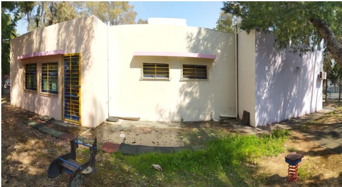
Εικόνα 5.1.4. Άποψη του κτιρίου από την Δυτική όψη
