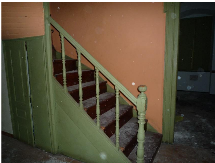
Σχήμα 2.23 Κλίμακα ανόδου στον Β' όροφο και τυπικό κιγκλίδωμα εποχής
