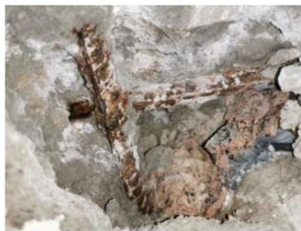
Σχήμα 4.10 Διάβρωση οπλισμών
