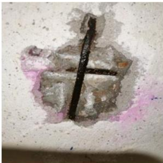
Σχήμα 4.9 Ενανθράκωση σκυροδέματος
