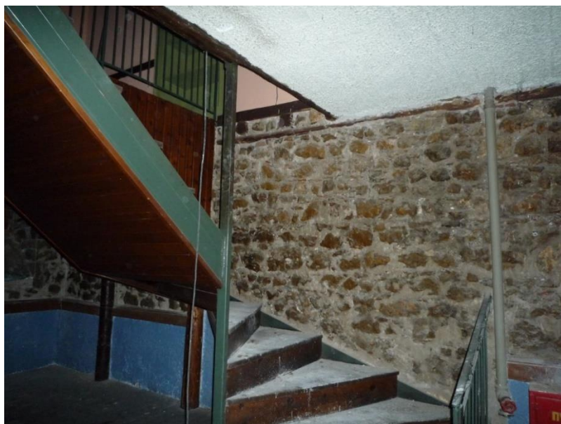
Σχήμα 2.18 Κλιμακοστάσιο ανόδου στον Α' όροφο
