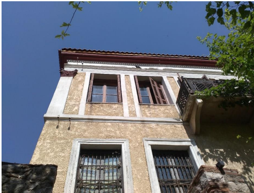
Σχήμα 2.35 Πλαισίωση ανοιγμάτων – παραστάδες Β' ορόφου με ανακλιντροειδή επίκρανα – επισήμανση κορωνίδας (Ανατολική όψη)
