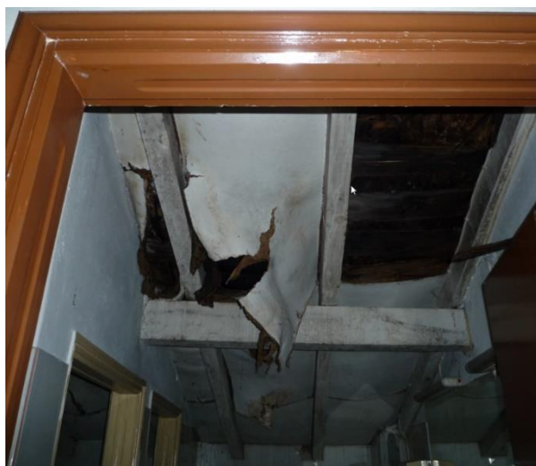
Σχήμα 2.39 Οροφή κτιρίου προσθήκης
