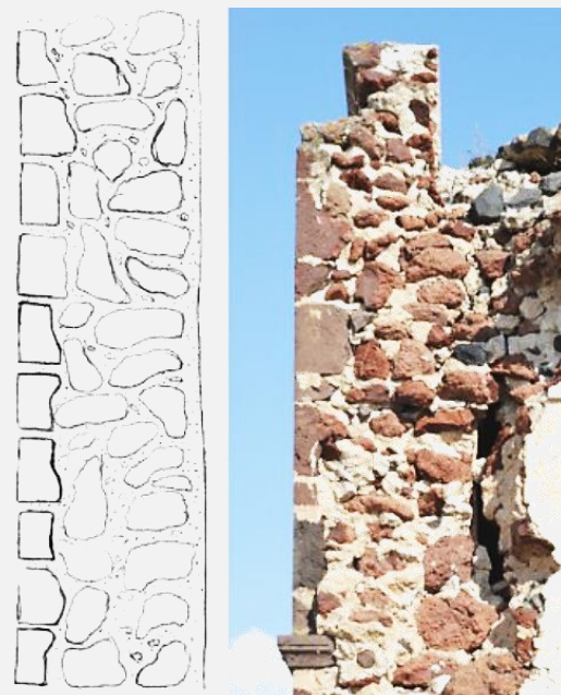
ΤΟΙΧΟΠΟΙΙΑ ΜΕ ΛΑΞΕΥΤΟΥΣ ΛΙΘΟΥΣ ΕΞΩΤΕΡΙΚΑ Εικόνα 30
